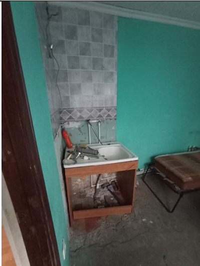
Фото № 17 Внутреннее состояние помещения
