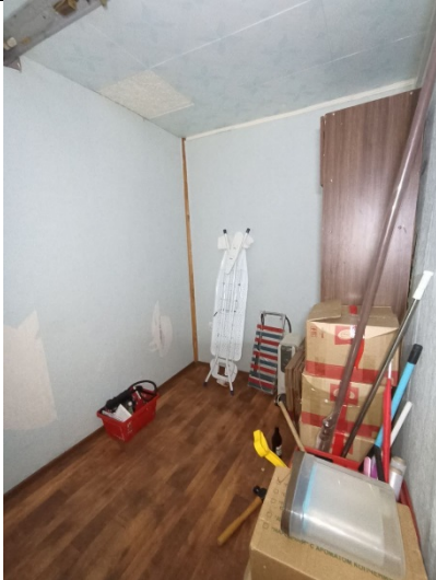
Фото № 15 Внутреннее состояние помещения
