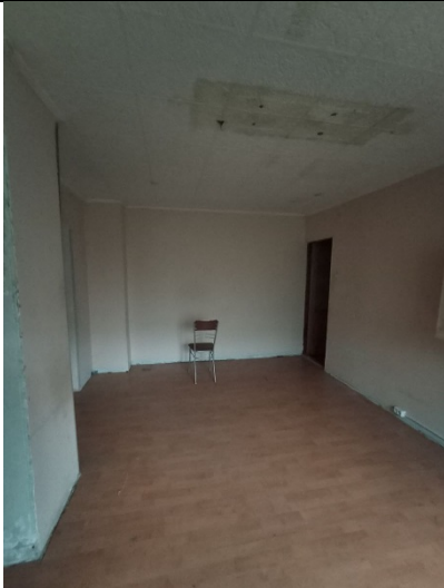
Фото № 19 Внутреннее состояние помещения
