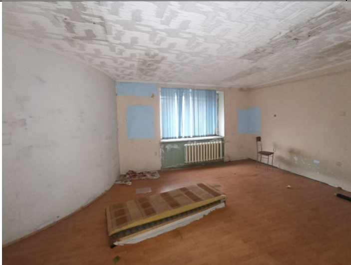
Фото № 11 Внутреннее состояние помещения
