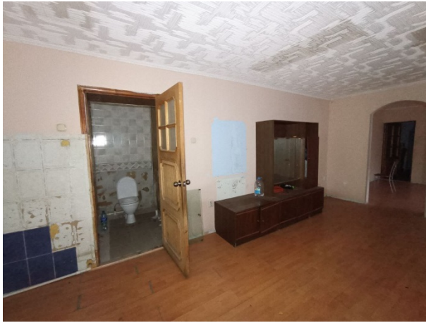
Фото № 9 Внутреннее состояние помещения
