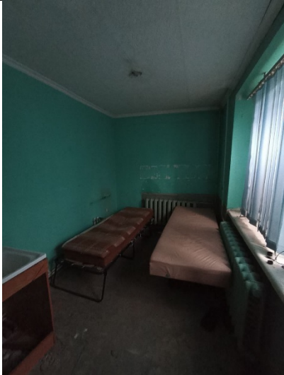
Фото № 21 Внутреннее состояние помещения
