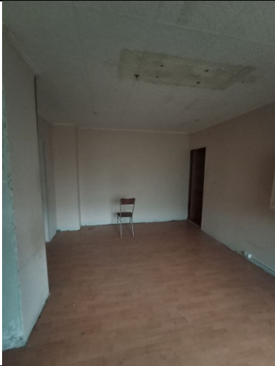
Фото № 19 Внутреннее состояние помещения
