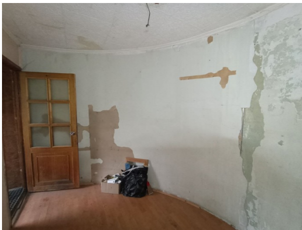
Фото № 7 Внутреннее состояние помещения
