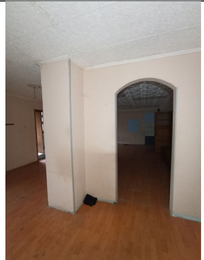
Фото № 12 Внутреннее состояние помещения
