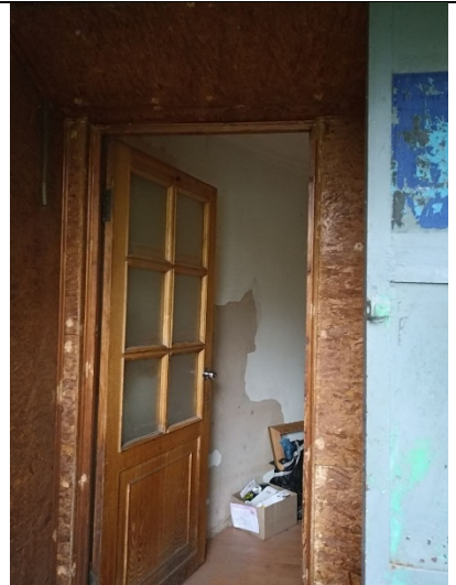
Фото № 18 Внутреннее состояние помещения
