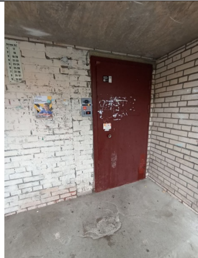
Фото № 6 Вход в парадную (общий вход в объект оценки)
