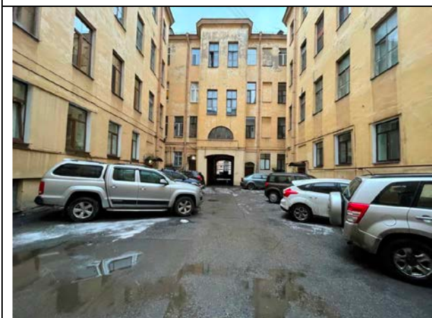
Фото 13. Внутри дворовая территория Объекта оценки
