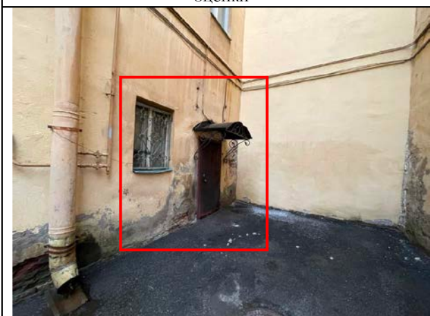
Фото 15. Входная и оконная группа Объекта оценки
