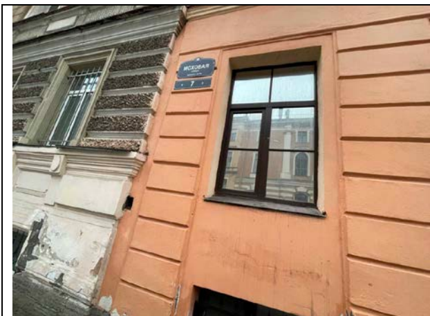
Фото 11. Адрес Объекта оценки
