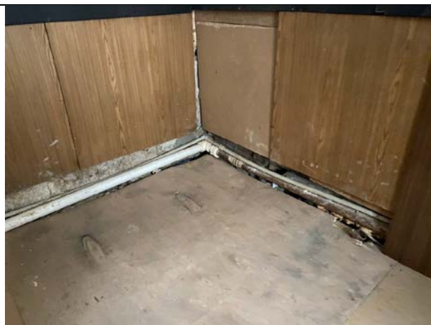
Фото № 18 – Внутреннее состояние помещения
