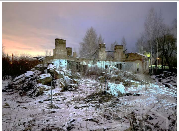
Фото № 8. Внешний вид земельного участка и здания
