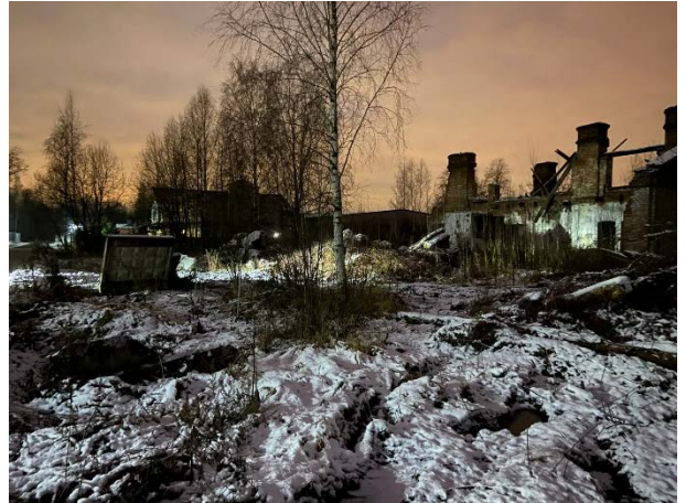
Фото № 4. Внешний вид земельного участка и здания
