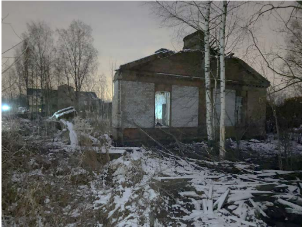
Фото № 3. Внешний вид земельного участка и здания
