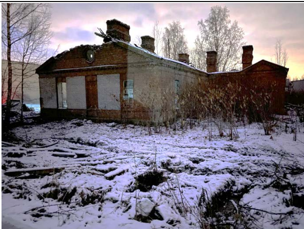
Фото № 7. Внешний вид земельного участка и здания
