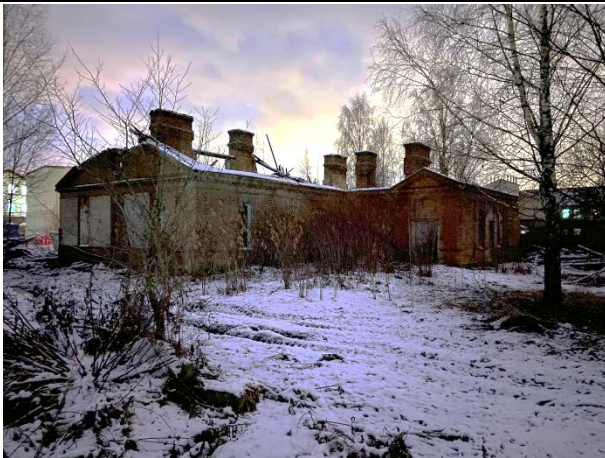
Фото № 5. Внешний вид земельного участка и здания
