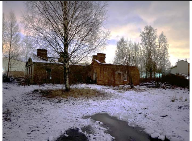
Фото № 6. Внешний вид земельного участка и здания
