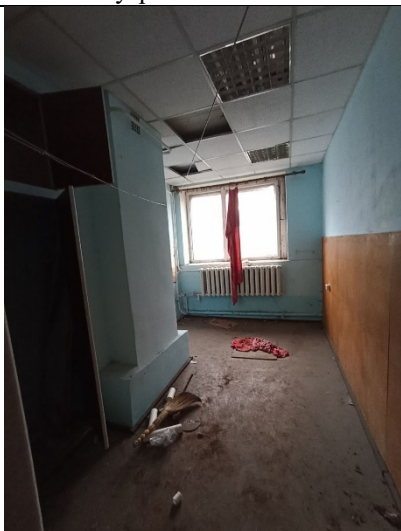
Фото № 17 – Внутреннее состояние помещения
