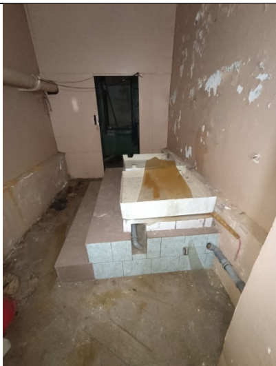
Фото № 13 – Внутреннее состояние помещения
