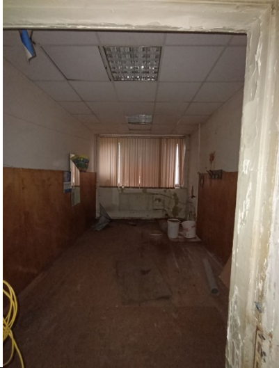
Фото № 23 – Внутреннее состояние помещения
