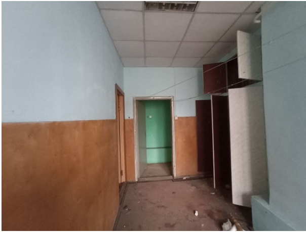
Фото № 19 – Внутреннее состояние помещения
