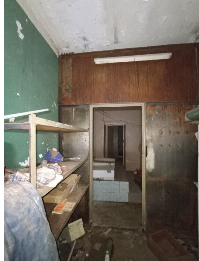
Фото № 8 – Внутреннее состояние помещения
