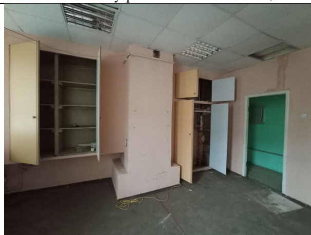
Фото № 16 – Внутреннее состояние помещения
