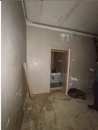
Фото № 11 – Внутреннее состояние помещения
