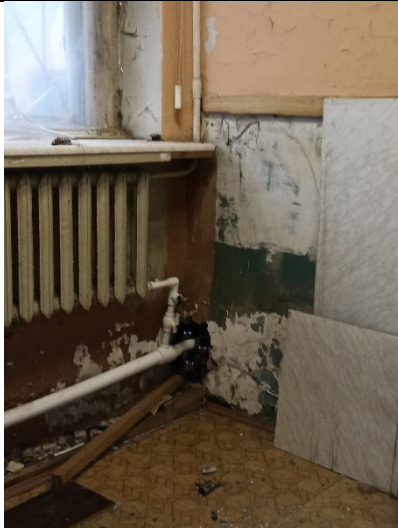
Фото № 29 – Внутреннее состояние помещения
