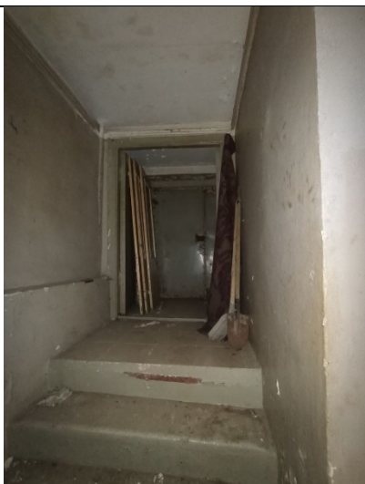
Фото № 31 – Внутреннее состояние помещения
