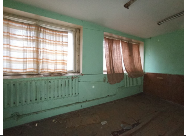
Фото № 26 – Внутреннее состояние помещения
