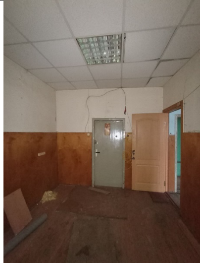
Фото № 20 – Внутреннее состояние помещения
