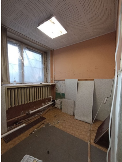
Фото № 27 – Внутреннее состояние помещения
