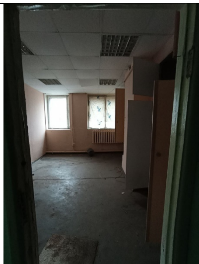
Фото № 32 – Внутреннее состояние помещения
