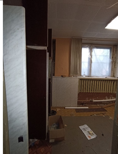
Фото № 28 – Внутреннее состояние помещения
