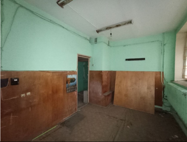
Фото № 25 – Внутреннее состояние помещения
