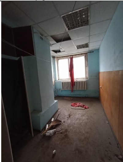
Фото № 17 – Внутреннее состояние помещения
