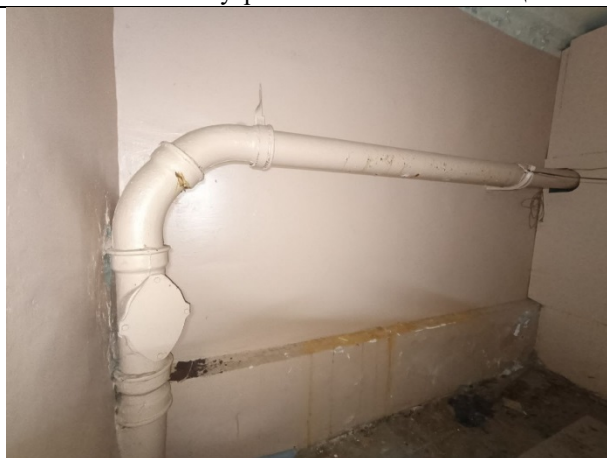
Фото № 15 – Внутреннее состояние помещения
