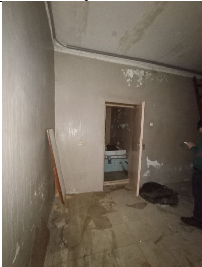
Фото № 11 – Внутреннее состояние помещения
