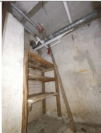
Фото № 14 – Внутреннее состояние помещения
