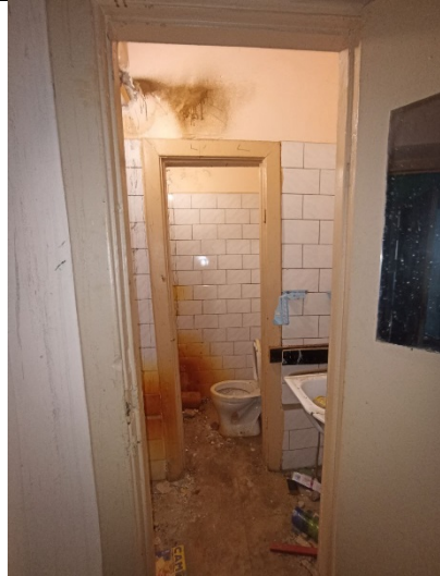
Фото № 22 – Внутреннее состояние помещения
