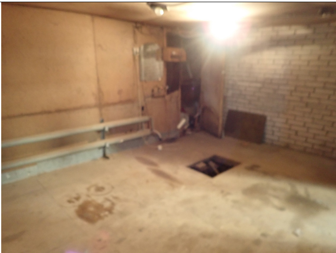
Описание: Внутри Объекта
