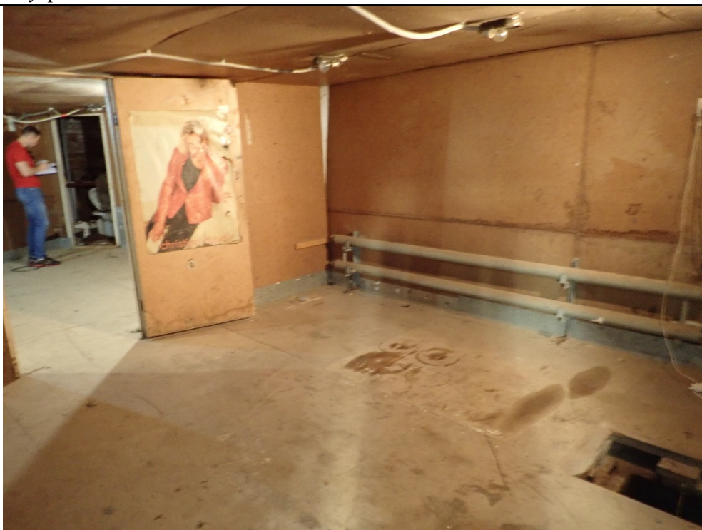
Описание: Внутри Объекта
