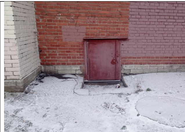
Фото № 7 – Вход в оцениваемое помещение
