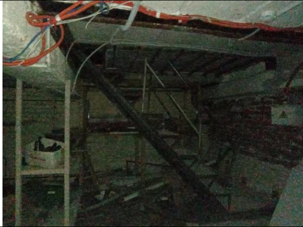
Фото № 17 – Внутреннее состояние помещения
