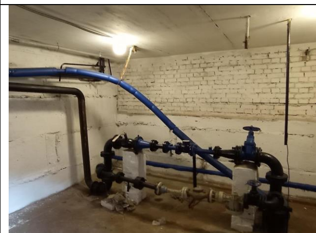
Фото № 9 – Внутреннее состояние помещения
