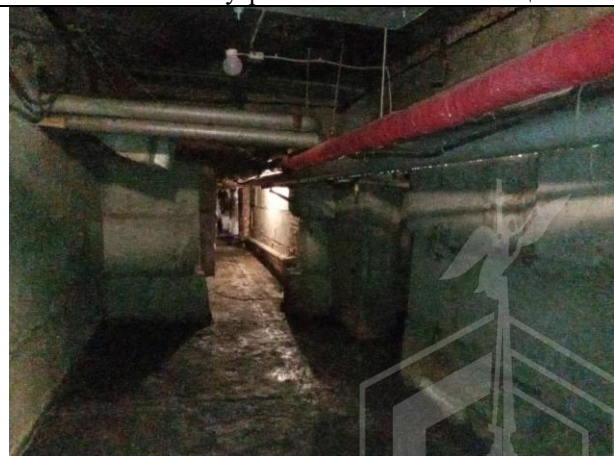
Фото № 14 – Внутреннее состояние помещения
