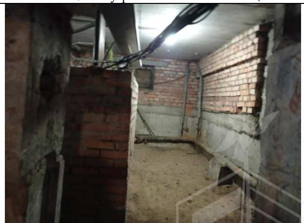
Фото № 22 – Внутреннее состояние помещения
