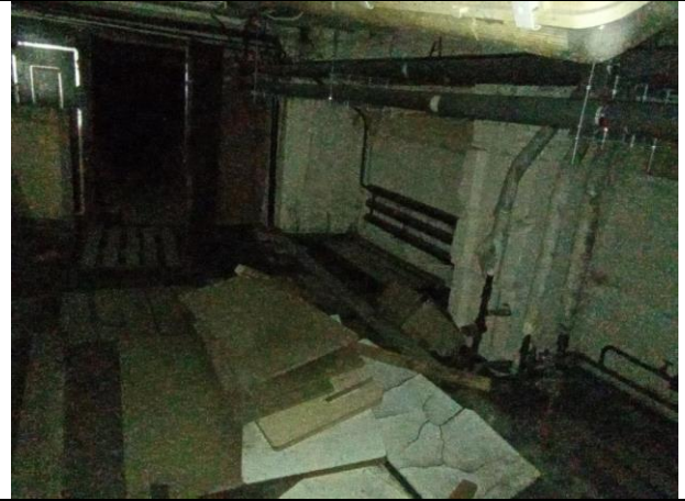
Фото № 16 – Внутреннее состояние помещения
