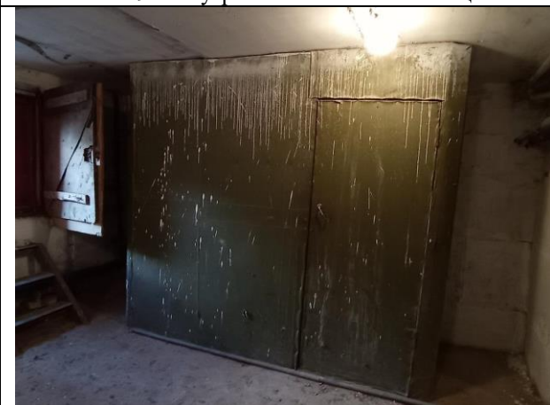
Фото № 11 – Внутреннее состояние помещения
