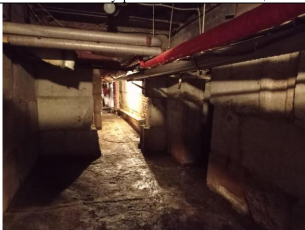
Фото № 19 – Внутреннее состояние помещения
