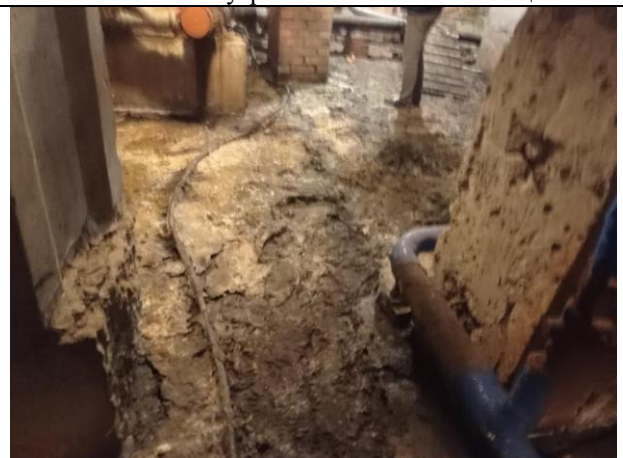
Фото № 20 – Внутреннее состояние помещения
