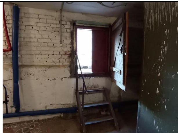
Фото № 8 – Вход в оцениваемое помещение (вид из помещения)
