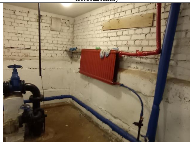
Фото № 10 – Внутреннее состояние помещения
