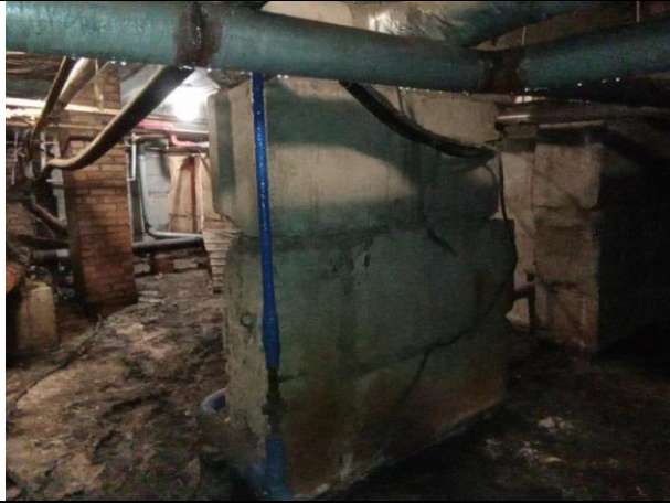
Фото № 15 – Внутреннее состояние помещения
