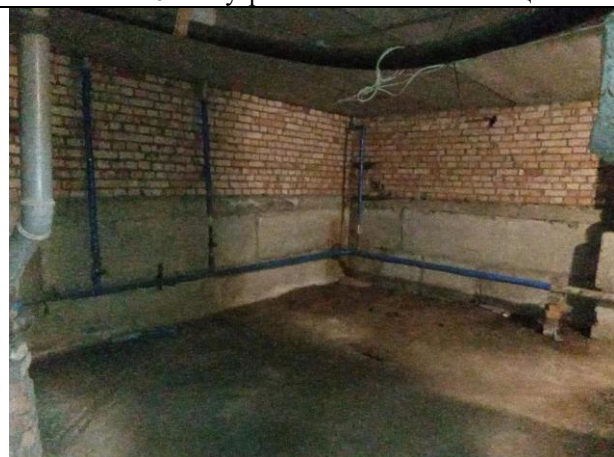
Фото № 12 – Внутреннее состояние помещения
