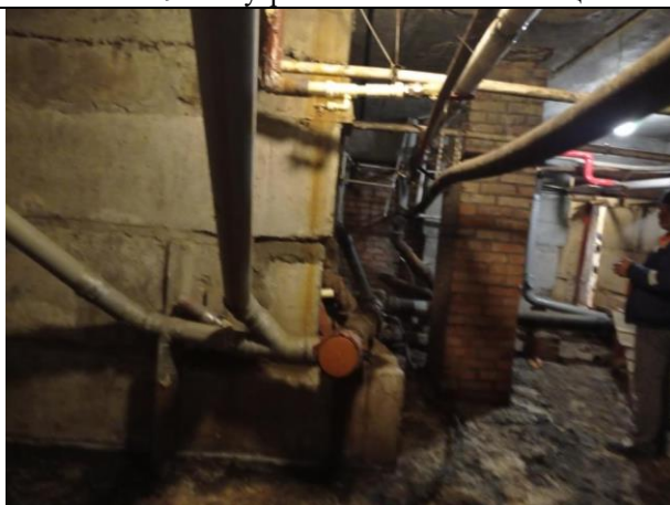
Фото № 21 – Внутреннее состояние помещения
