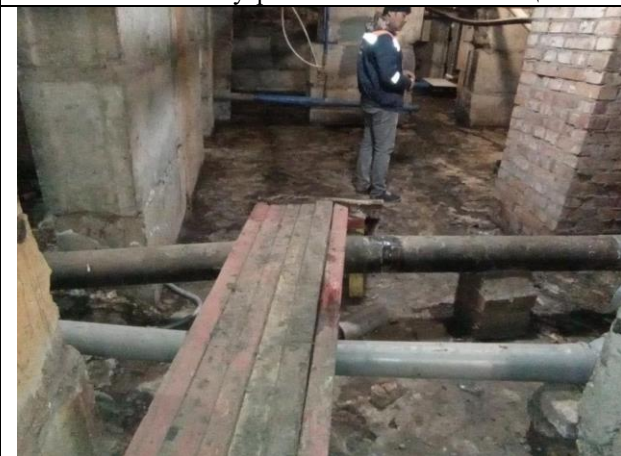
Фото № 13 – Внутреннее состояние помещения
