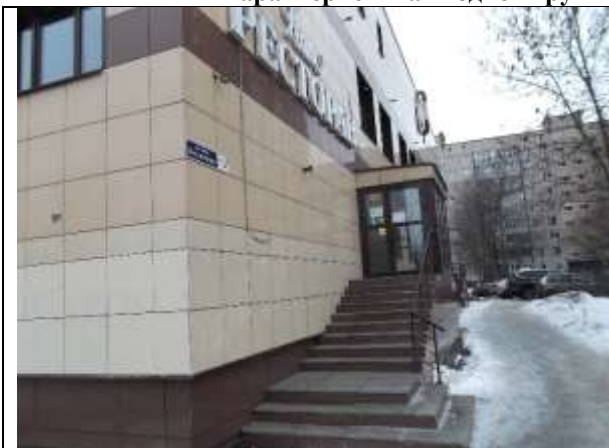
Фото 5. Общий вход с улицы
