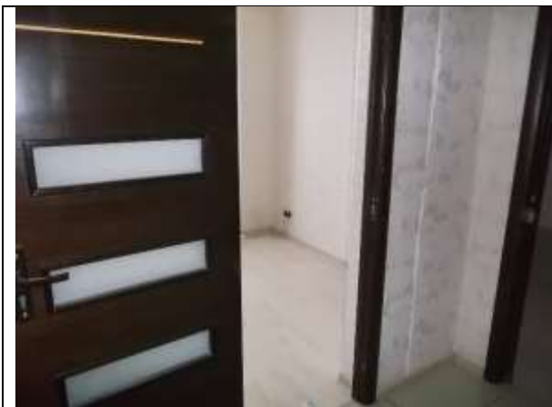
Фото 13. Внутреннее состояние Объекта оценки
