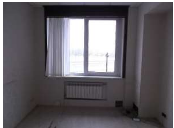
Фото 14. Внутреннее состояние Объекта оценки
