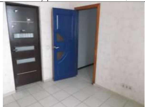
Фото 24. Внутреннее состояние Объекта оценки
