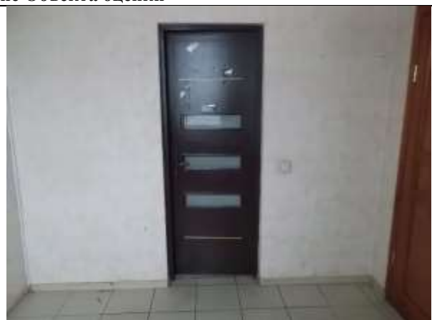
Фото 8. Внутреннее состояние Объекта оценки
