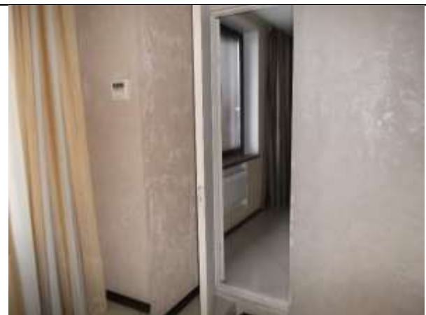
Фото 22. Внутреннее состояние Объекта оценки
