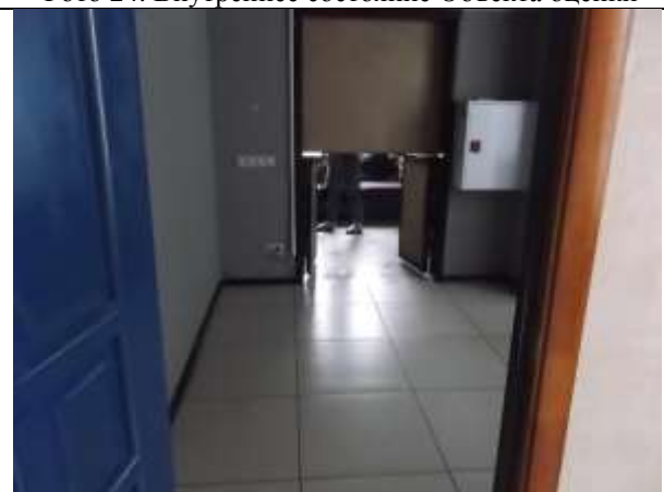
Фото 26. Внутреннее состояние Объекта оценки
