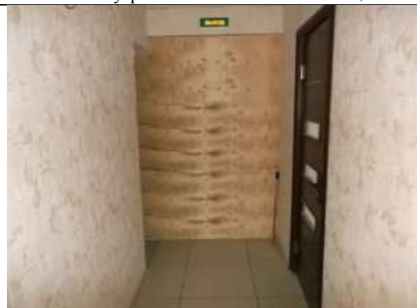
Фото 9. Внутреннее состояние Объекта оценки
