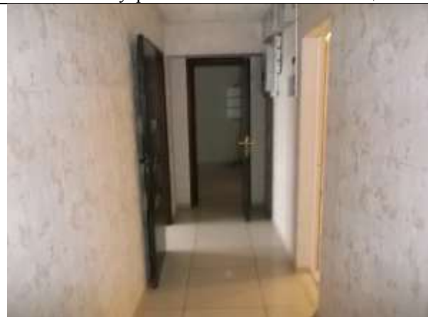
Фото 11. Внутреннее состояние Объекта оценки
