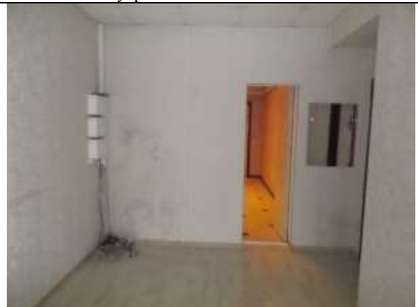
Фото 16. Внутреннее состояние Объекта оценки
