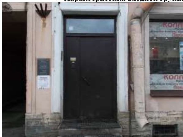
Фото 6. Доступ Объекта оценки. Общий вход с улицы
