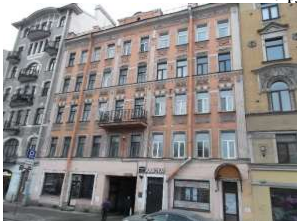
Фото 1. Вид здания Объекта оценки с улицы
