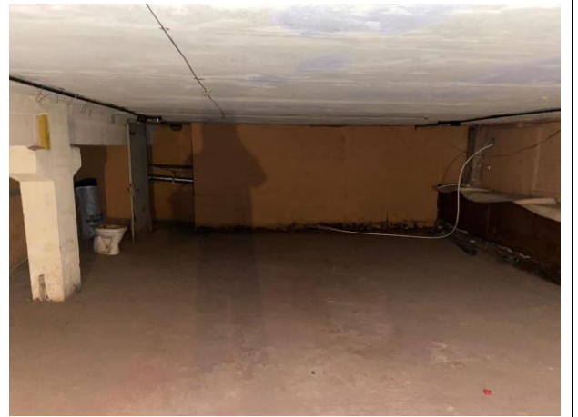
Фото 8 Вид помещения 2-Н
