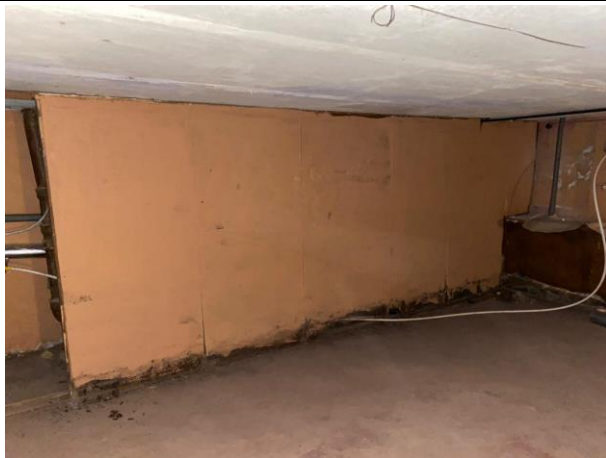
Фото 9 Вид помещения 2-Н
