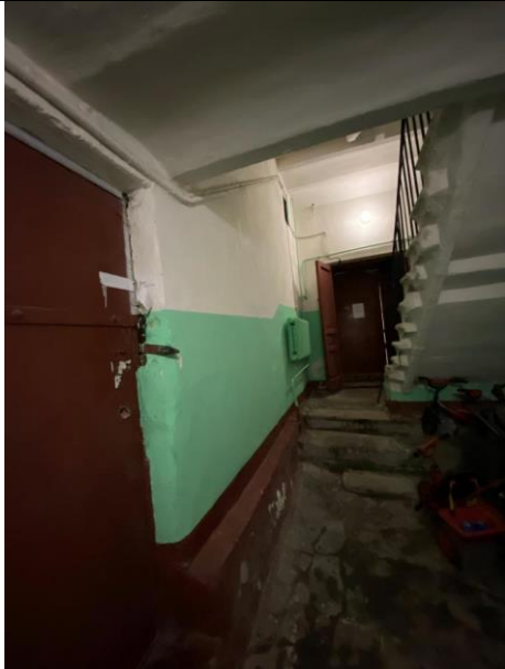
Фото № 7 – Вход в помещение (парадная)
