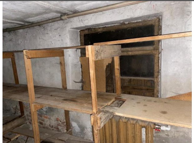
Фото № 10 – Внутреннее состояние помещения
