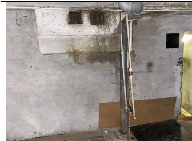
Фото № 13 – Внутреннее состояние помещения
