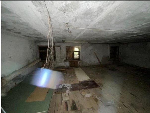
Фото № 11 – Внутреннее состояние помещения
