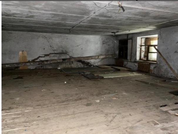
Фото № 9 – Внутреннее состояние помещения
