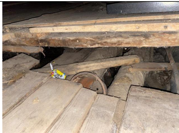
Фото № 14 – Внутреннее состояние помещения
