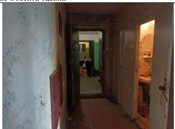
Фото 10. Внутреннее состояние Объекта оценки
