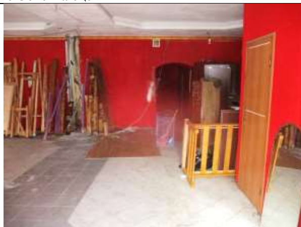
Фото 8. Внутреннее состояние Объекта оценки
