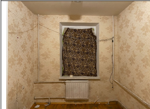
Фото 15 Вид помещения 6-Н
