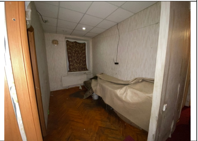
Фото 18 Вид помещения 6-Н
