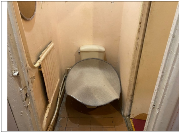
Фото 13 Вид помещения 6-Н
