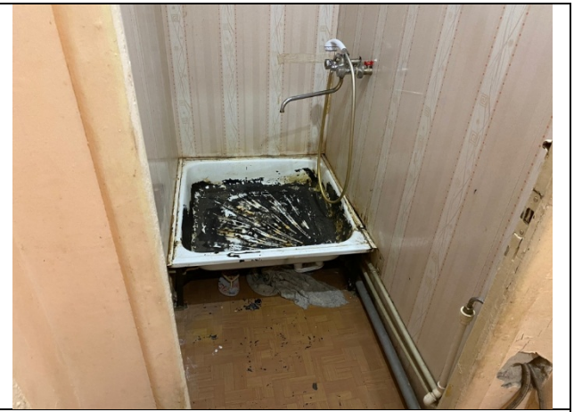
Фото 14 Вид помещения 6-Н
