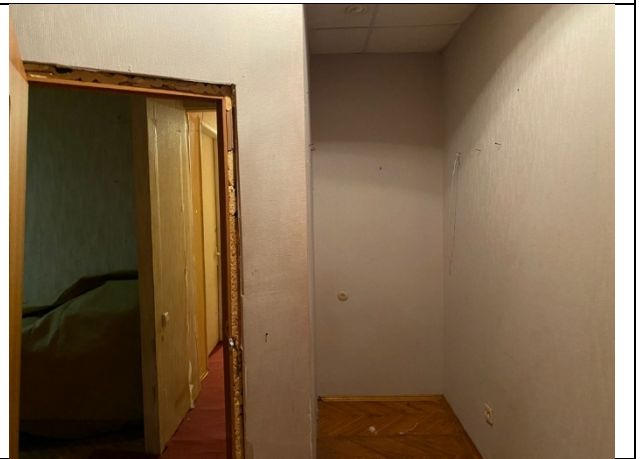
Фото 24 Вид помещения 6-Н
