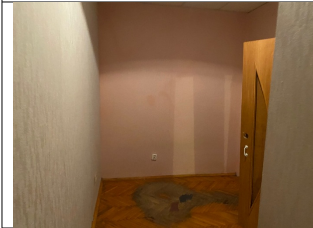
Фото 23 Вид помещения 6-Н
