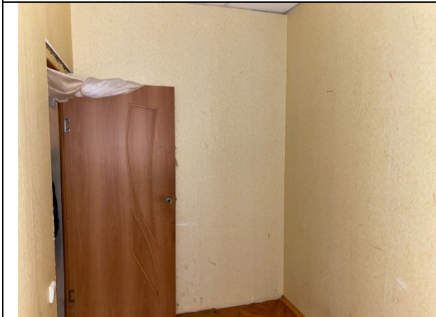
Фото 21 Вид помещения 6-Н
