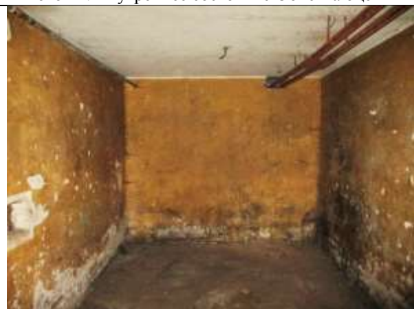
Фото 23. Внутреннее состояние Объекта оценки
