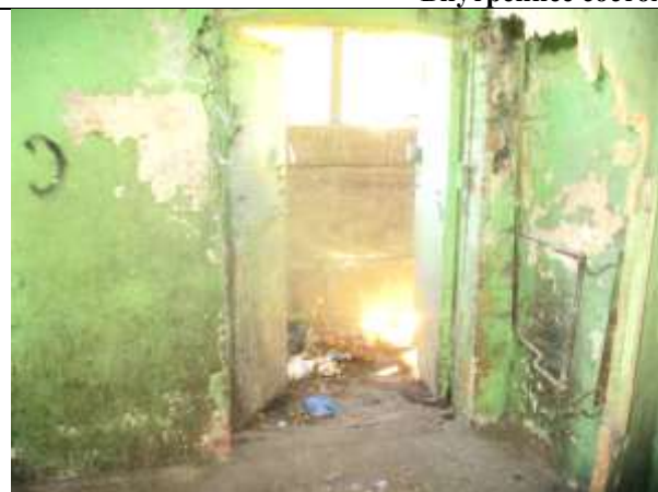
Фото 11. Внутреннее состояние Объекта оценки
