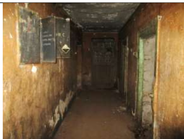
Фото 18. Внутреннее состояние Объекта оценки
