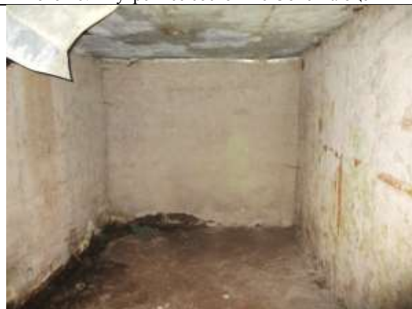
Фото 22. Внутреннее состояние Объекта оценки
