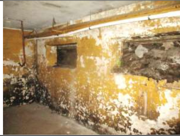
Фото 25. Внутреннее состояние Объекта оценки
