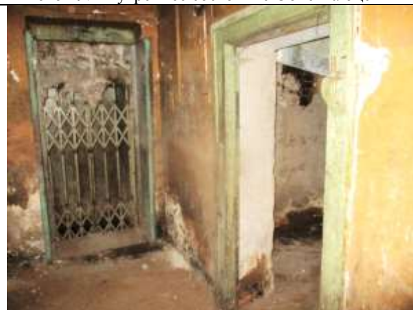
Фото 21. Внутреннее состояние Объекта оценки
