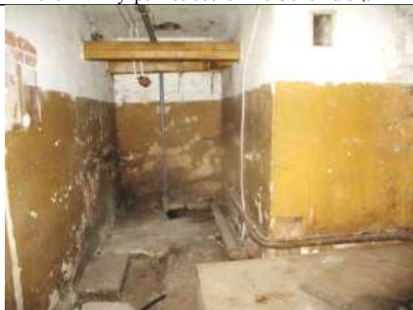
Фото 16. Внутреннее состояние Объекта оценки
