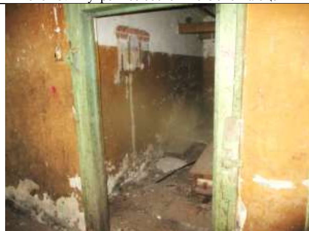
Фото 15. Внутреннее состояние Объекта оценки
