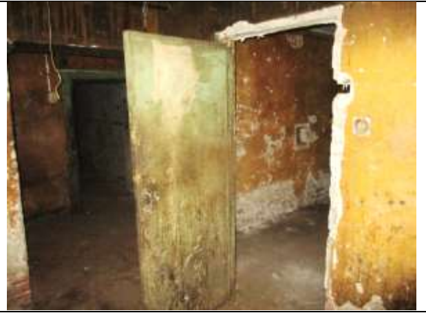
Фото 26. Внутреннее состояние Объекта оценки
