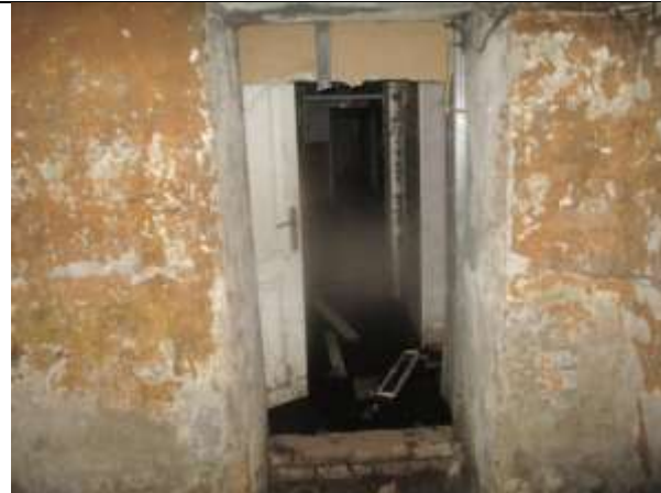
Фото 27. Внутреннее состояние Объекта оценки
