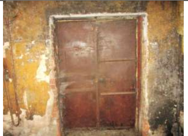
Фото 28. Внутреннее состояние Объекта оценки
