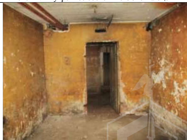
Фото 24. Внутреннее состояние Объекта оценки
