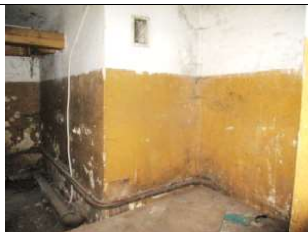
Фото 17. Внутреннее состояние Объекта оценки
