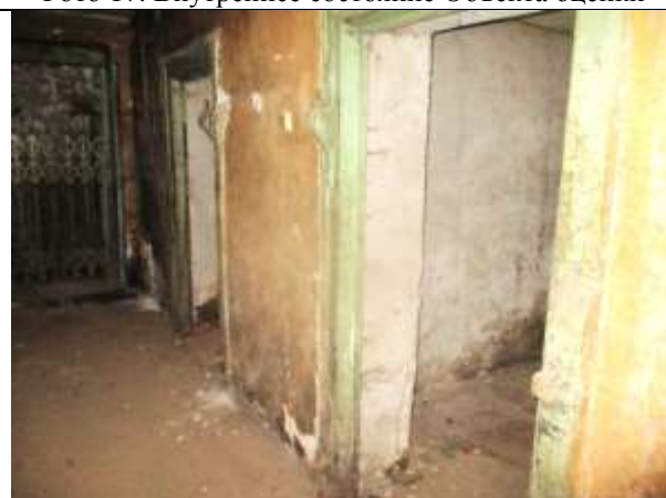
Фото 19. Внутреннее состояние Объекта оценки
