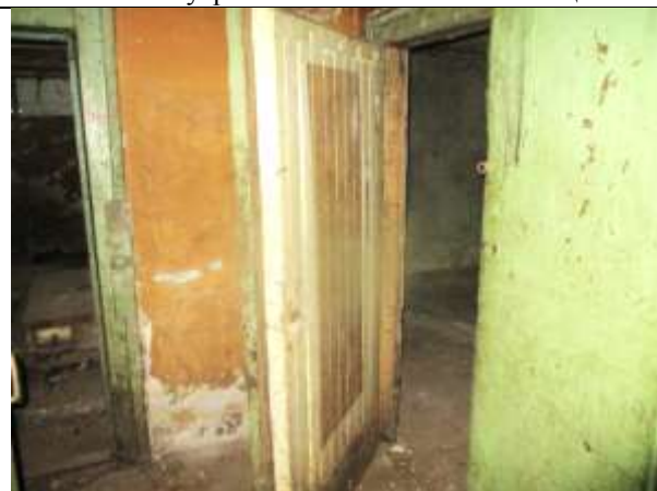
Фото 13. Внутреннее состояние Объекта оценки
