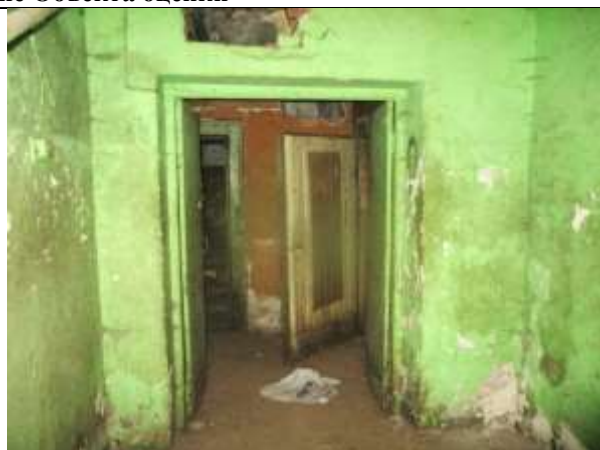
Фото 12. Внутреннее состояние Объекта оценки
