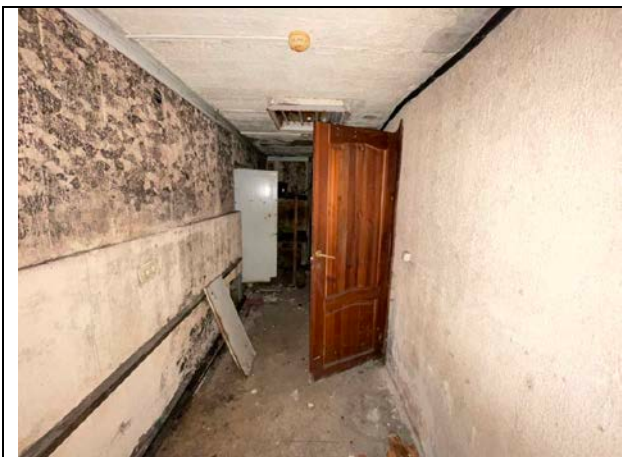
Фото 21. Типичное состояние Объекта оценки
