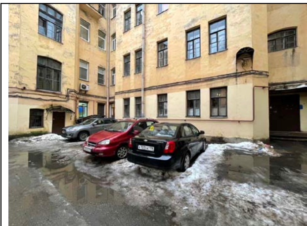
Фото 13. Вид здания расположения Объекта оценки
