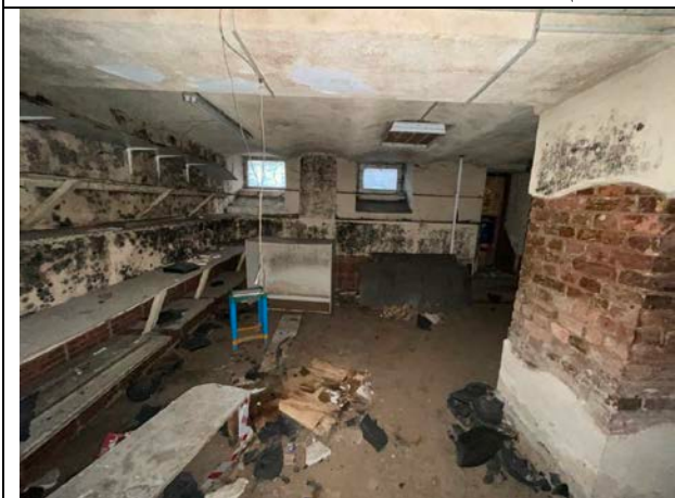
Фото 31. Типичное состояние Объекта оценки
