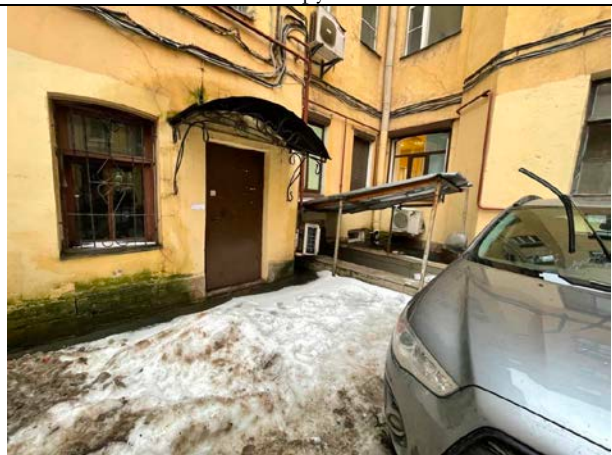
Фото 16. Внутри дворовая территория Объекта оценки
