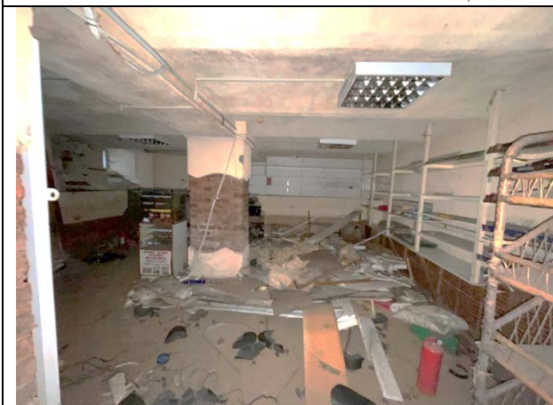
Фото 27. Типичное состояние Объекта оценки
