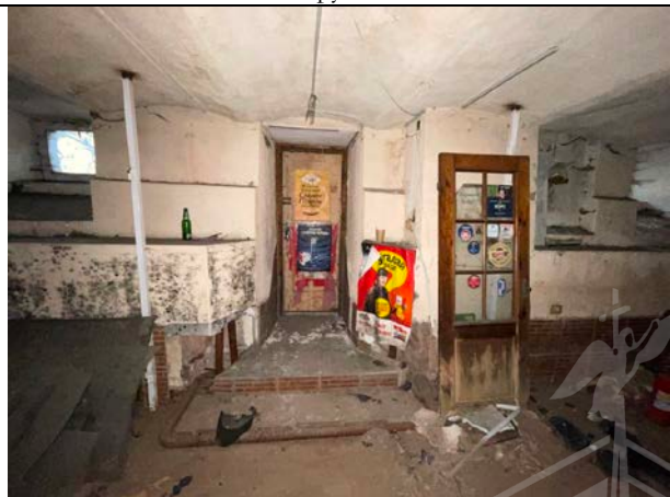
Фото 20. Вход в Объект оценки (вид изнутри помещения)
