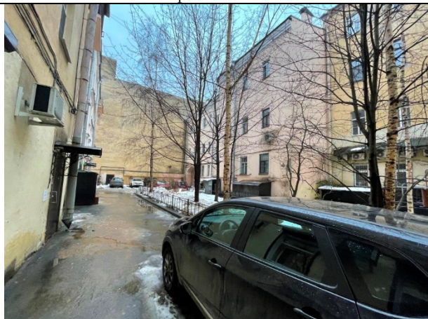
Фото 15. Внутри дворовая территория Объекта оценки
