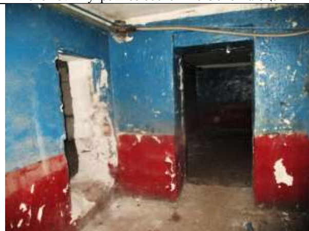
Фото 17. Внутреннее состояние Объекта оценки
