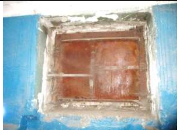
Фото 16. Внутреннее состояние Объекта оценки
