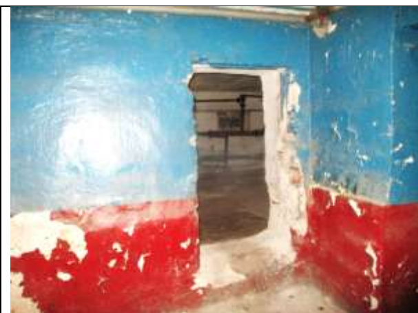
Фото 21. Внутреннее состояние Объекта оценки
