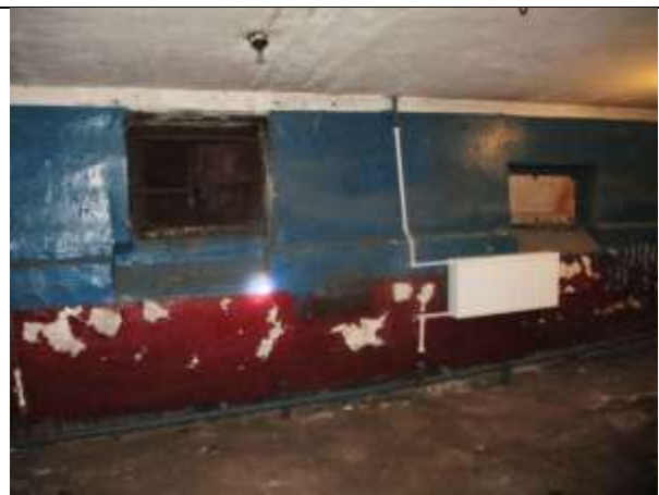
Фото 14. Внутреннее состояние Объекта оценки
