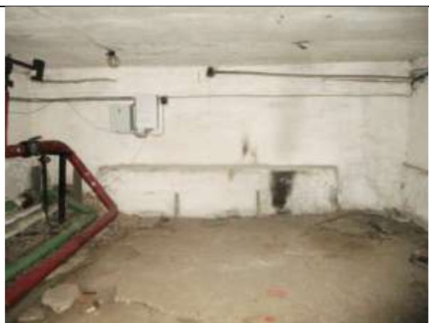
Фото 22. Внутреннее состояние Объекта оценки
