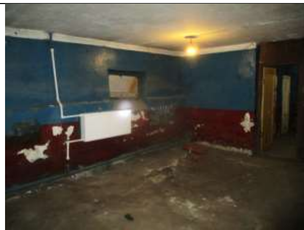
Фото 13. Внутреннее состояние Объекта оценки
