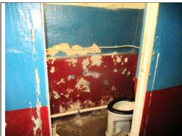
Фото 29. Внутреннее состояние Объекта оценки
