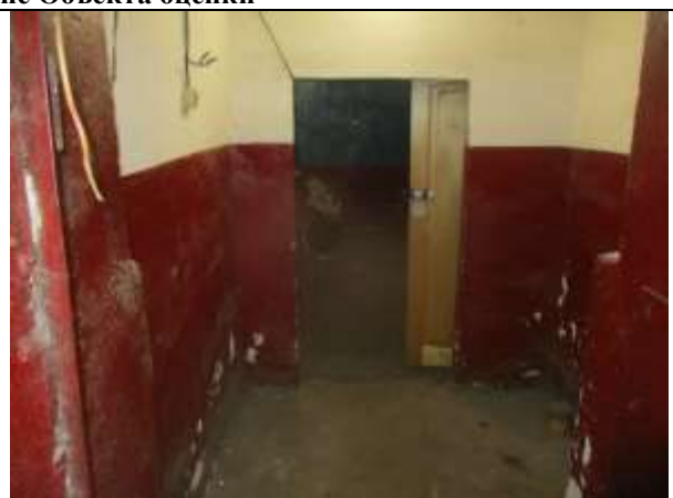
Фото 10. Внутреннее состояние Объекта оценки
