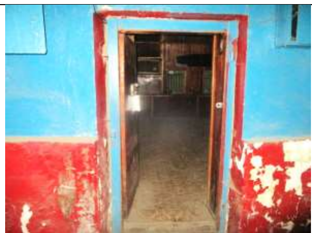
Фото 30. Внутреннее состояние Объекта оценки
