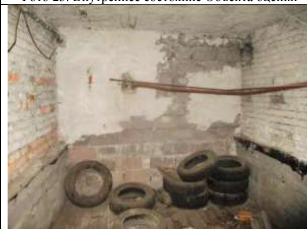
Фото 25. Внутреннее состояние Объекта оценки
