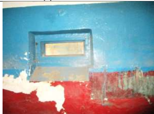
Фото 19. Внутреннее состояние Объекта оценки
