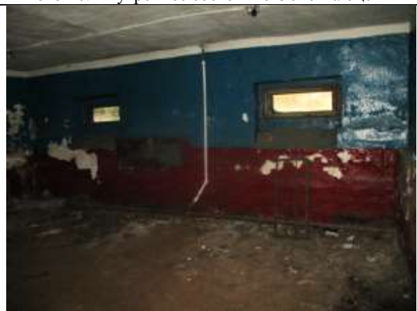
Фото 18. Внутреннее состояние Объекта оценки
