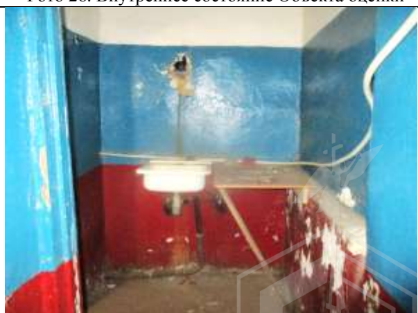
Фото 28. Внутреннее состояние Объекта оценки
