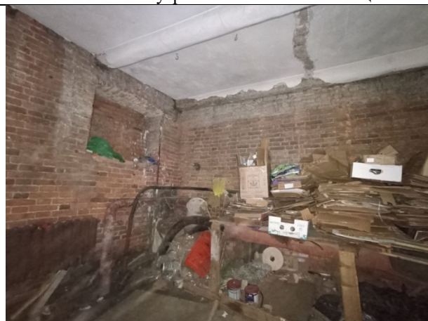
Фото № 14 – Внутреннее состояние помещения
