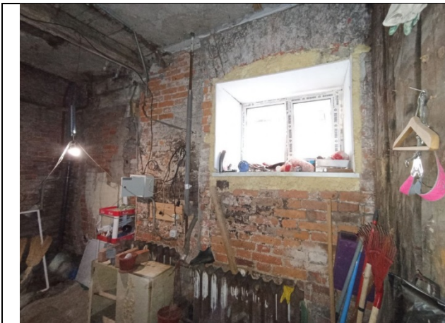
Фото № 11 – Внутреннее состояние помещения
