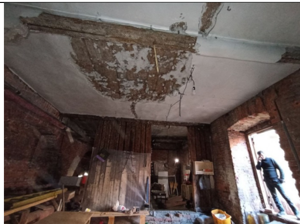
Фото № 12 – Внутреннее состояние помещения
