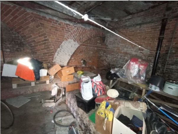
Фото № 9 – Внутреннее состояние помещения
