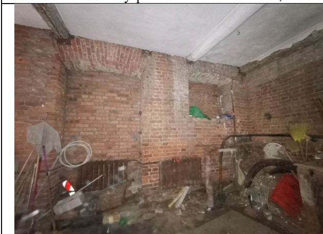
Фото № 13 – Внутреннее состояние помещения
