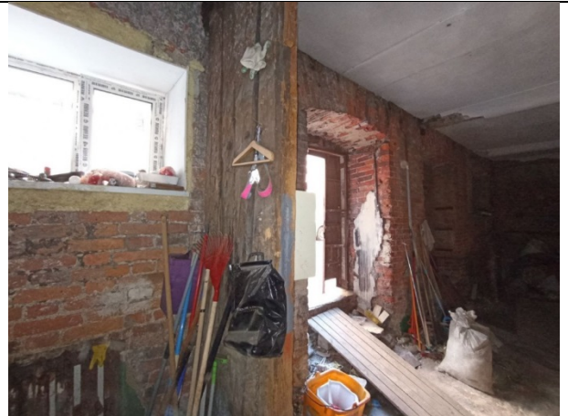
Фото № 8 – Внутреннее состояние помещения
