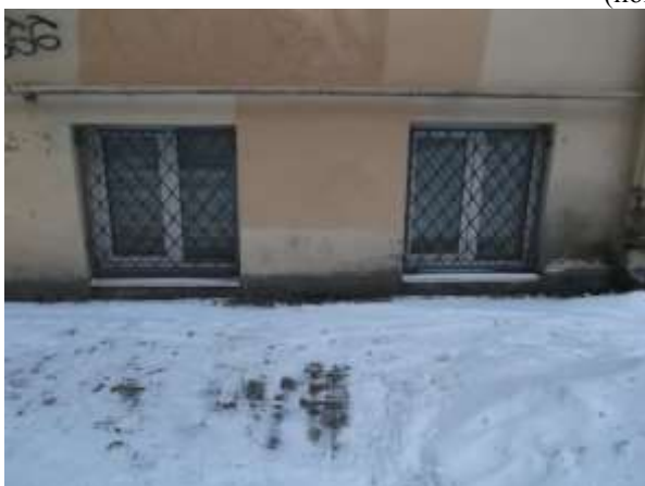
Фото 11. Окна Объекта оценки (пом. 6-Н)
