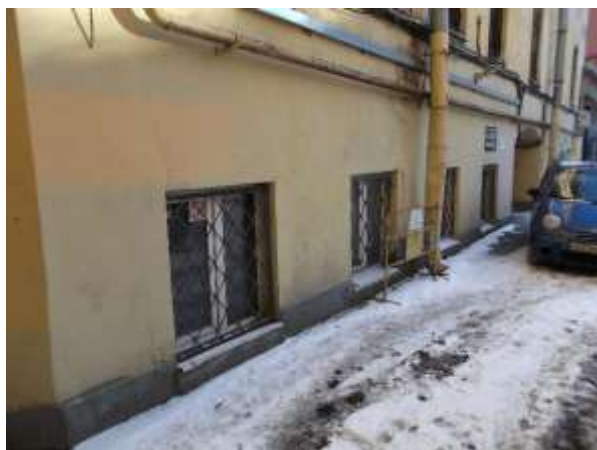
Фото 7. Окна Объекта оценки (пом. 2-Н)
