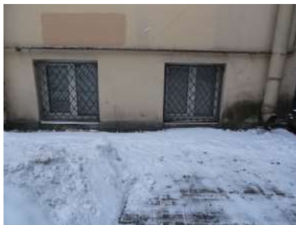
Фото 8. Окна Объекта оценки (пом. 2-Н)
