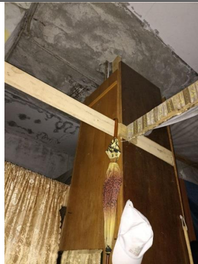
Фото № 8. Внутреннее состояние помещения
