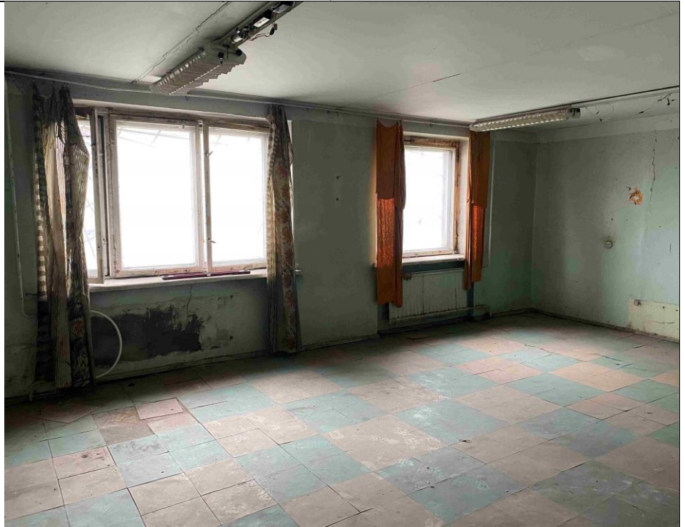
Описание: Вид внутри Объекта (ч.п. 12)
