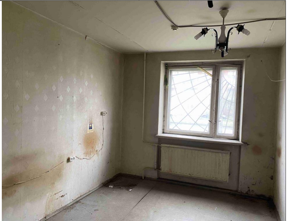
Описание: Вид внутри Объекта (ч.п. 10)
