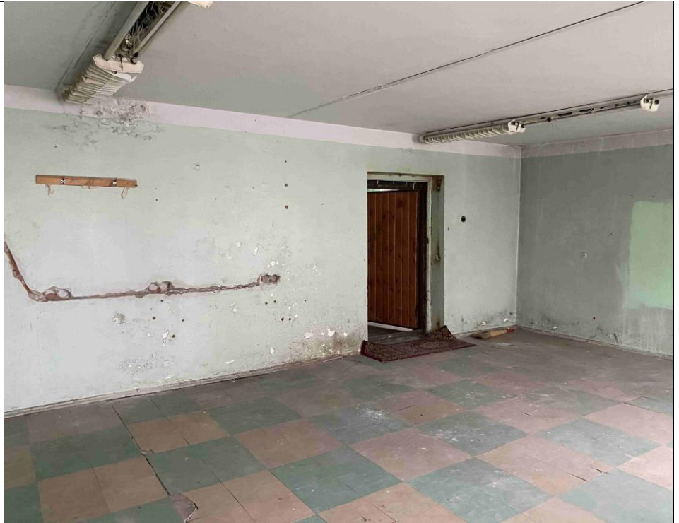
Описание: Вид внутри Объекта (ч.п. 12)
