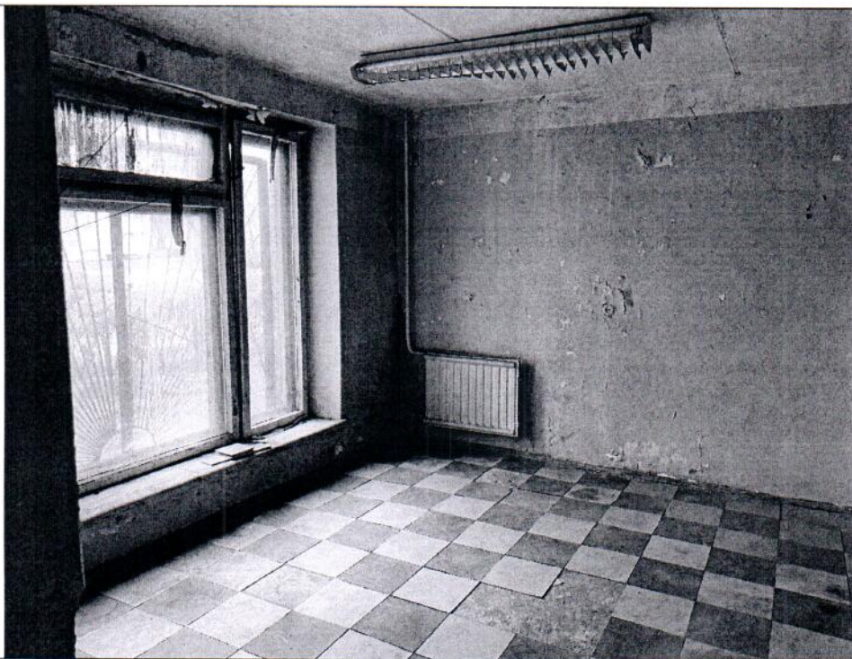
Описание: Вид внутри Объекта (ч.п. 8)
