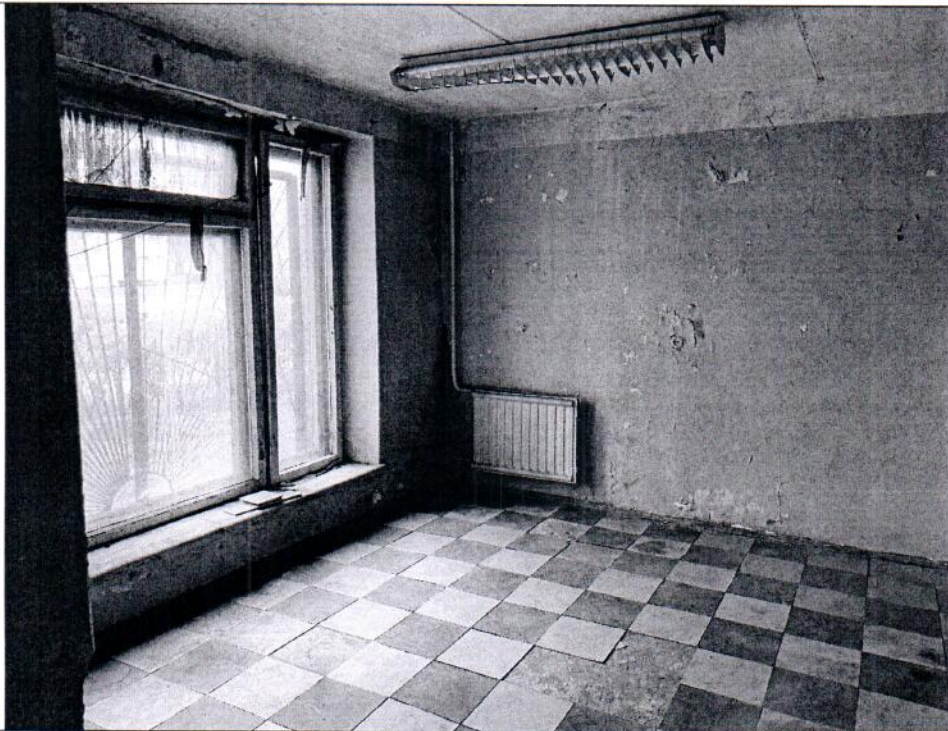
Описание: Вид внутри Объекта (ч.п. 8)
