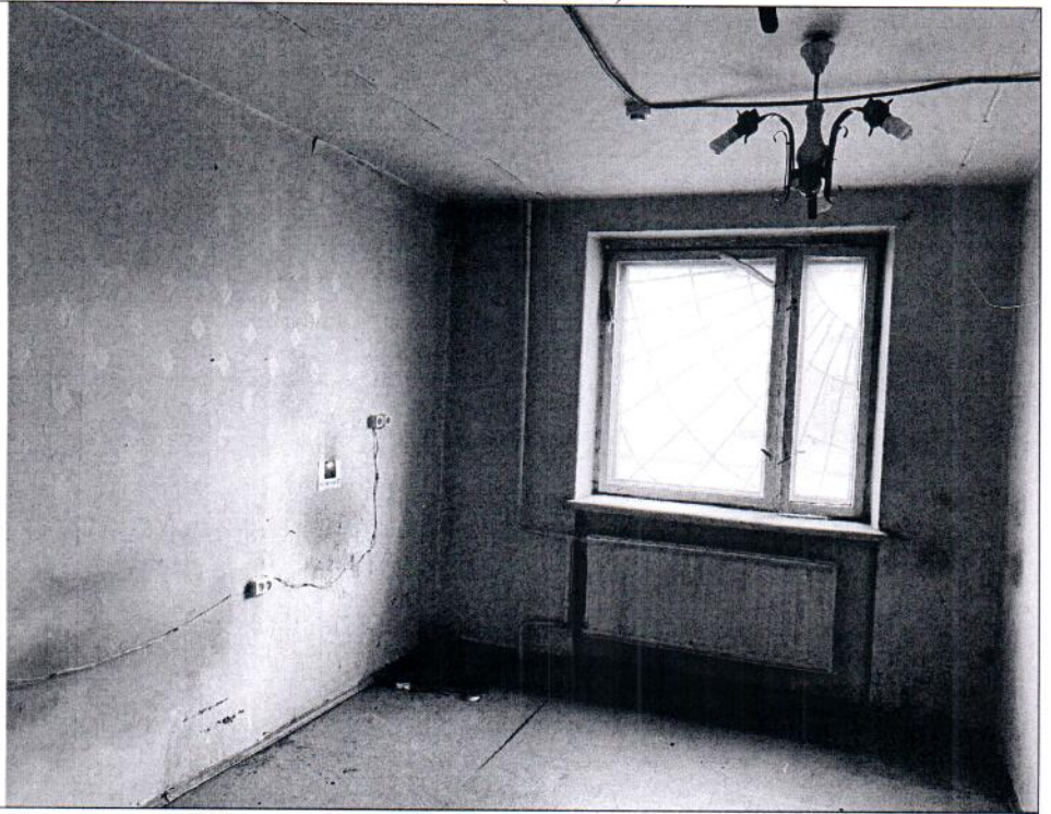
Описание: Вид внутри Объекта (ч.п. 10)
