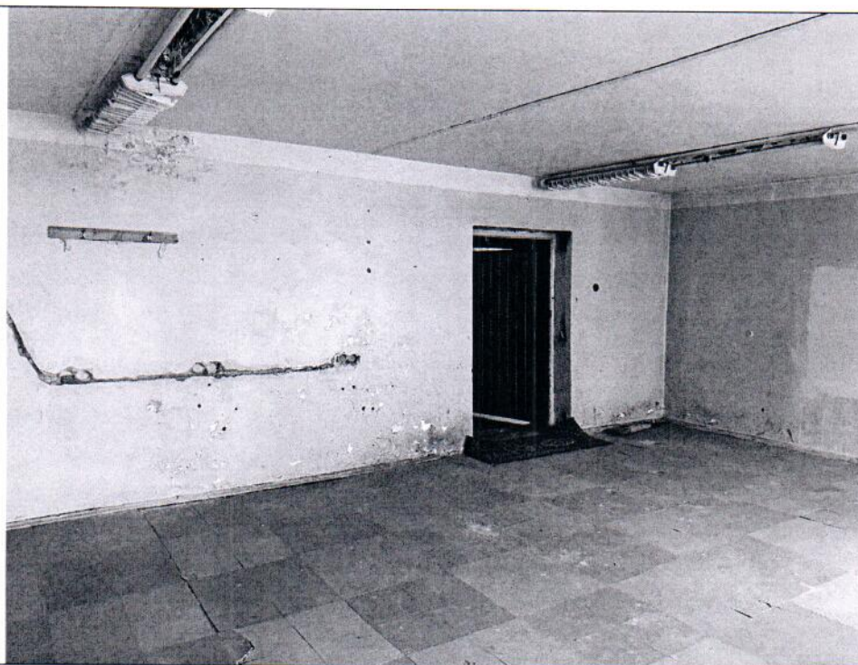
Описание: Вид внутри Объекта (ч.п. 12)
