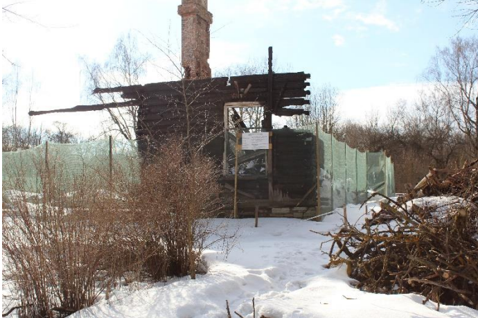
Фото № 1. Вид с северо-восточного угла на Восточный и Северный фасады
