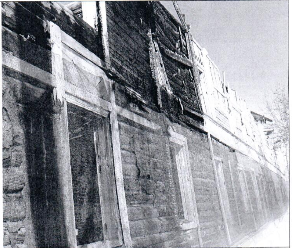
Описание: Вид на Объект
