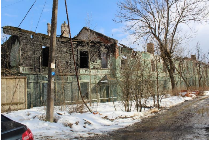
Фото № 1. Вид на Западный фасад
