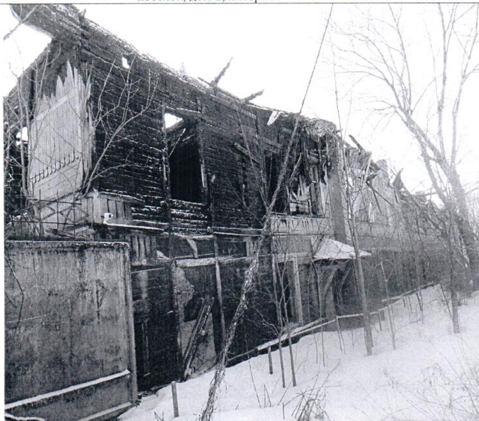
Описание: Вид на Объект
