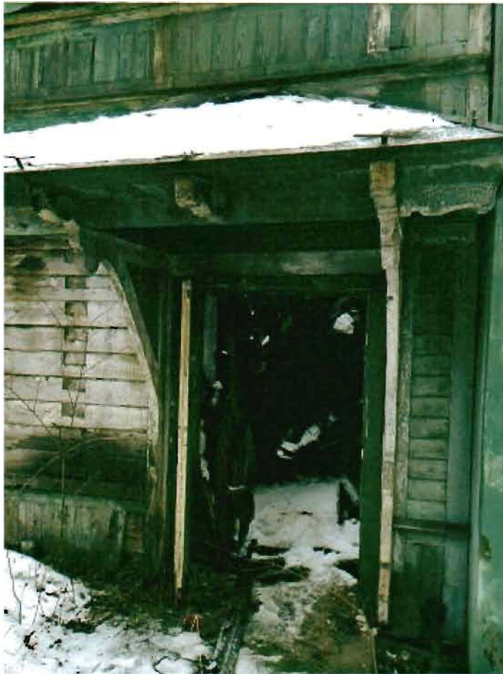
Фото 3. Крыльцо западного фасада.
