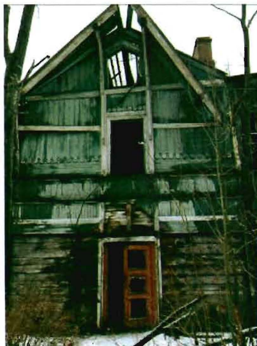
Фото 2. Часть западного фасада.
