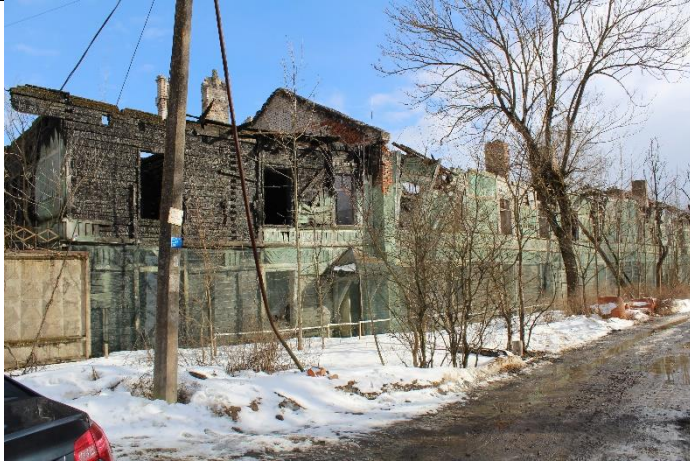
Фото № 1. Вид на Западный фасад
