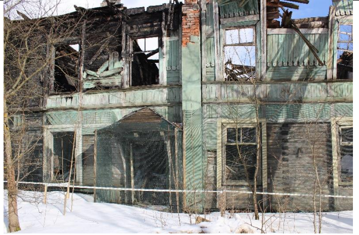
Фото № 2. Вид на фрагмент Западного фасада
