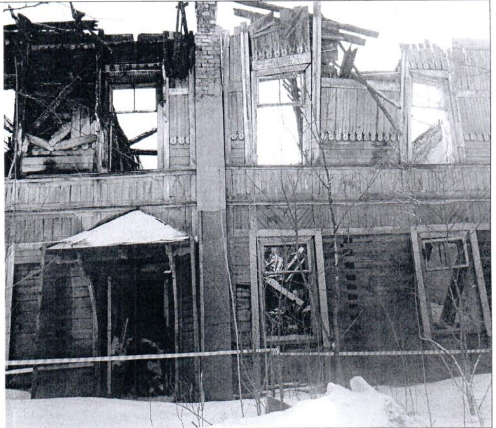
Описание: Вид на Объект
