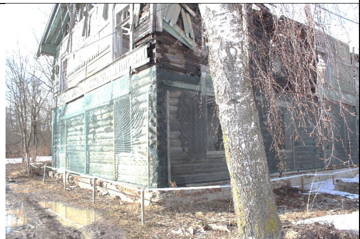
Фото № 9. Вид с юго-восточного угла
