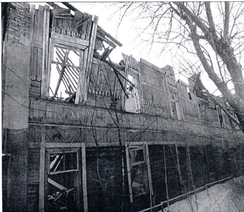
Описание: Вид на Объект
