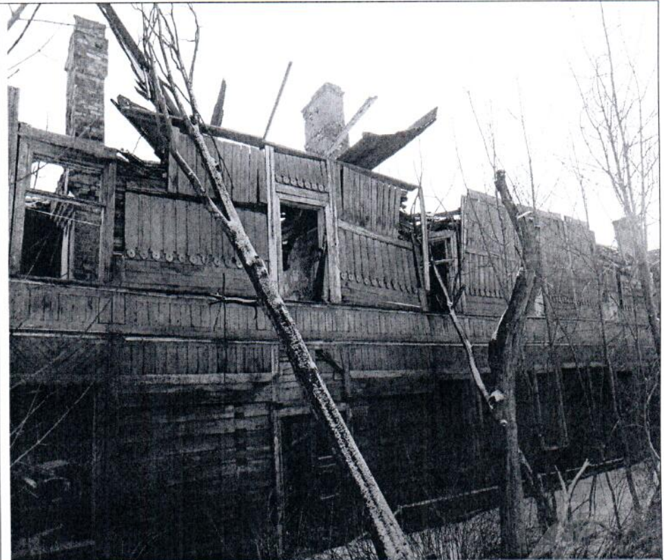
Описание: Вид на Объект
