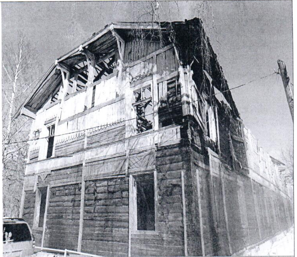
Описание: Вид на Объект
