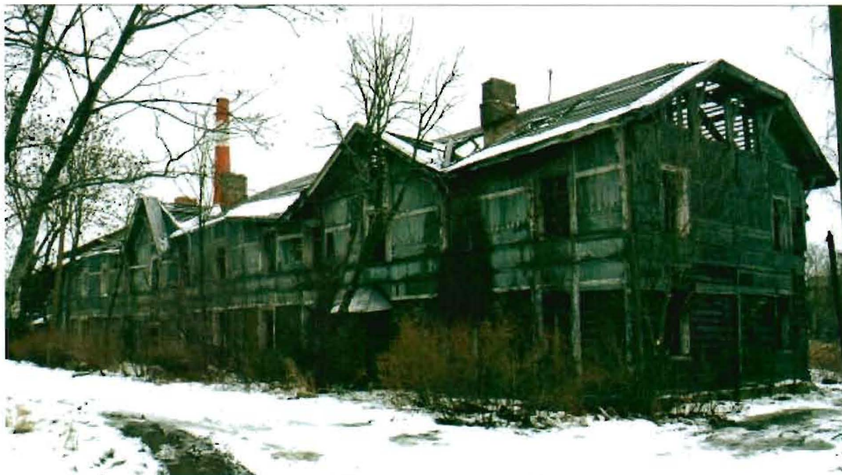
Фото 1. Южный и западный фасад.
