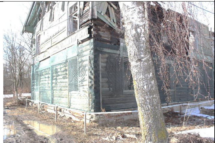
Фото № 9. Вид с юго-восточного угла
