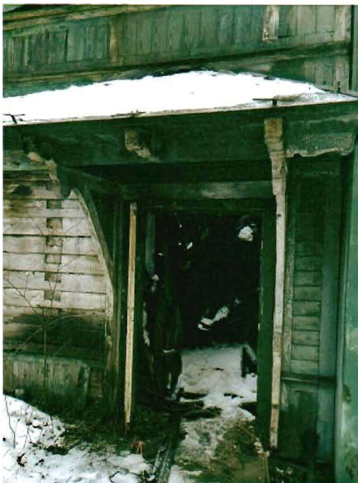
Фото 3. Крыльцо западного фасада.
