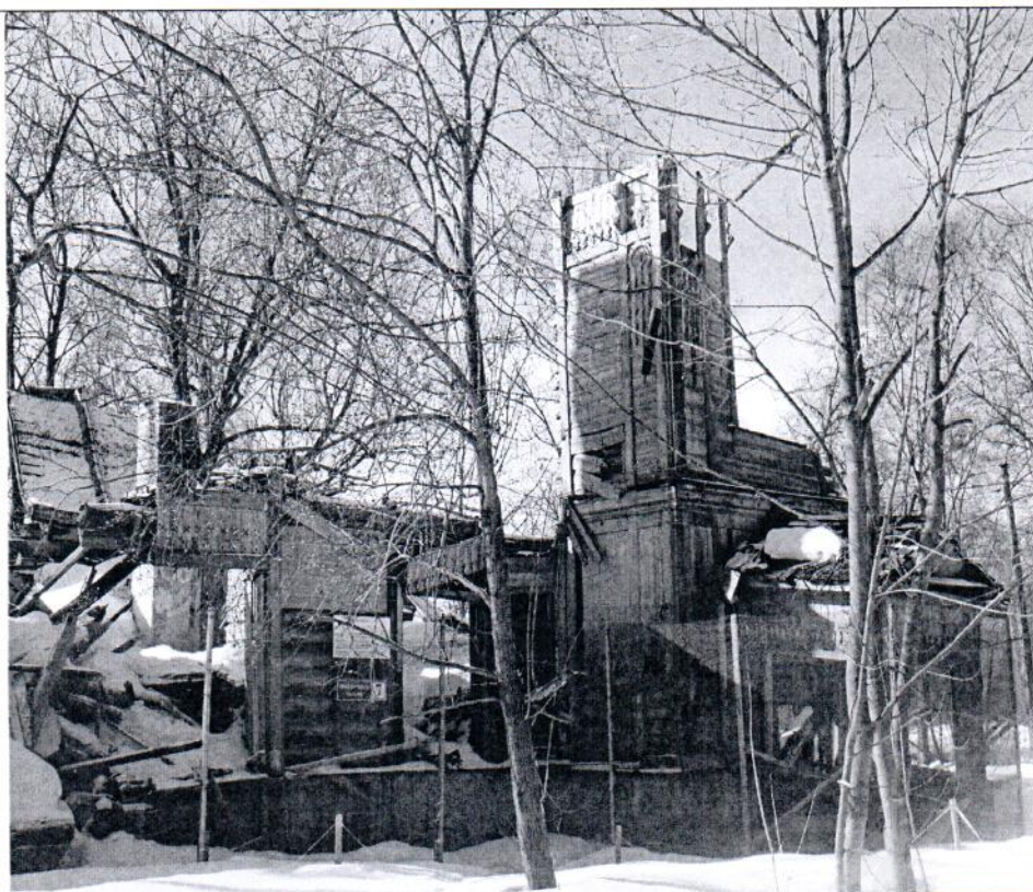
Описание: Вид на Объект
