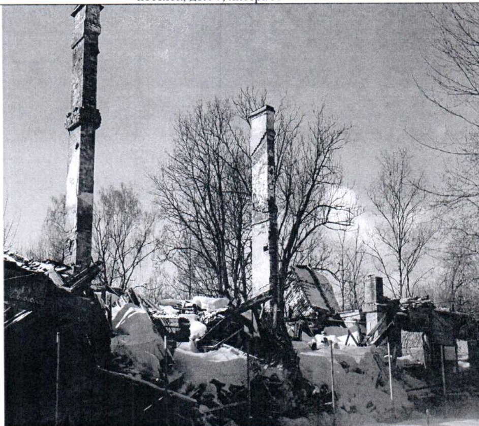
Описание: Вид на Объект
