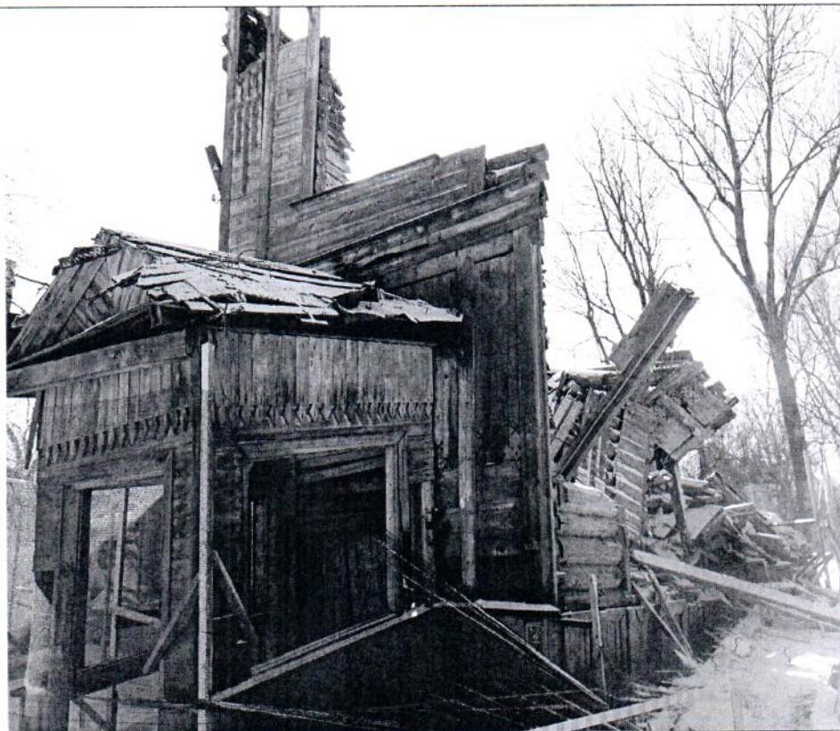
Описание: Вид на Объект
