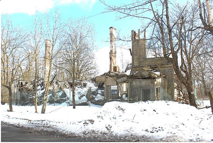
Фото № 1. Вид на Северный и, частично, Западный фасады
