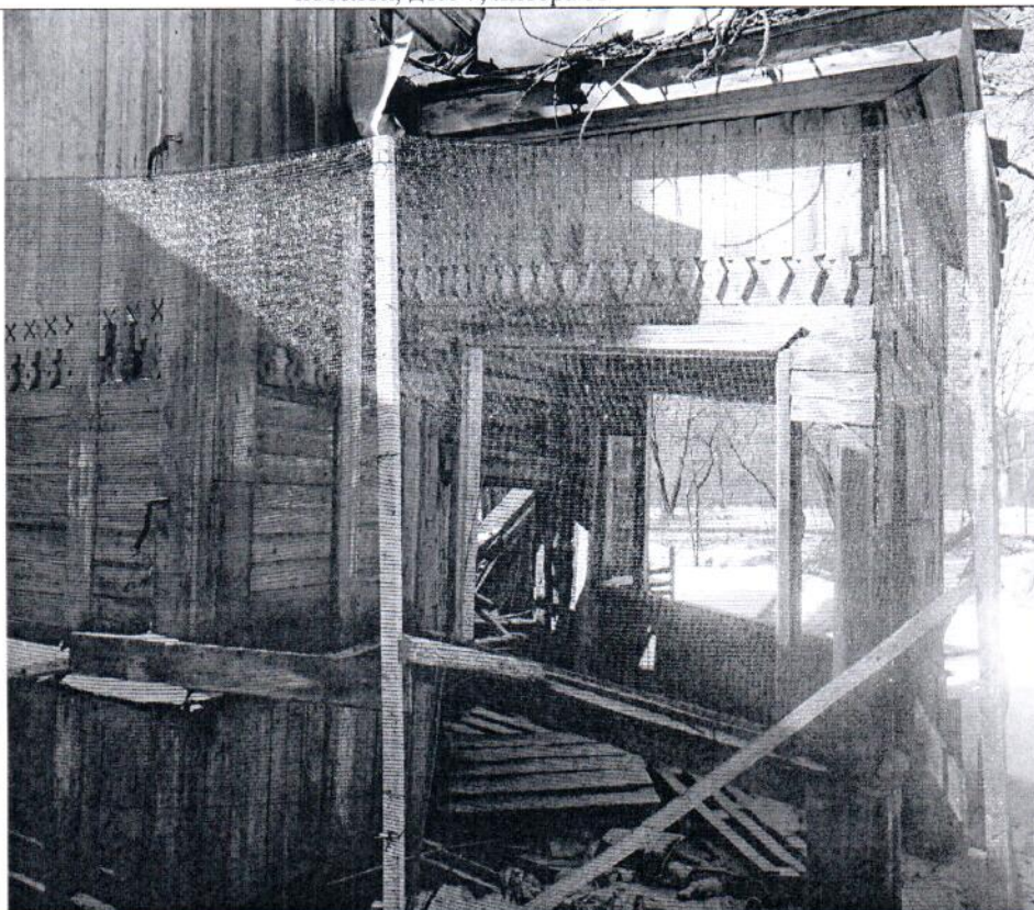
Описание: Вид на Объект
