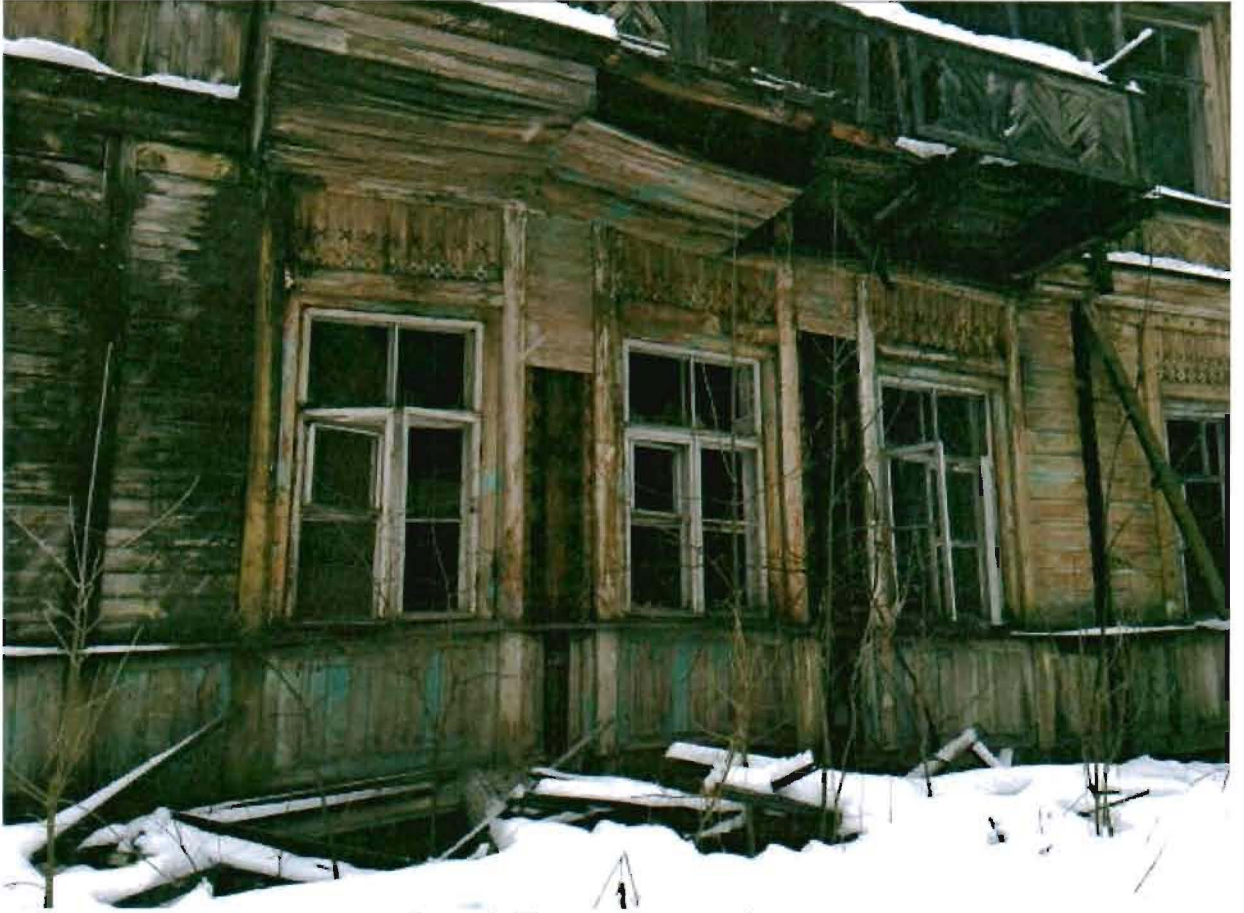
Фото 3. Часть северный фасад.
