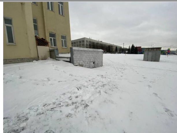
Фото № 7. Внешний вид земельного участка и здания
