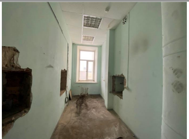
Фото № 37. Внутреннее состояние здания
