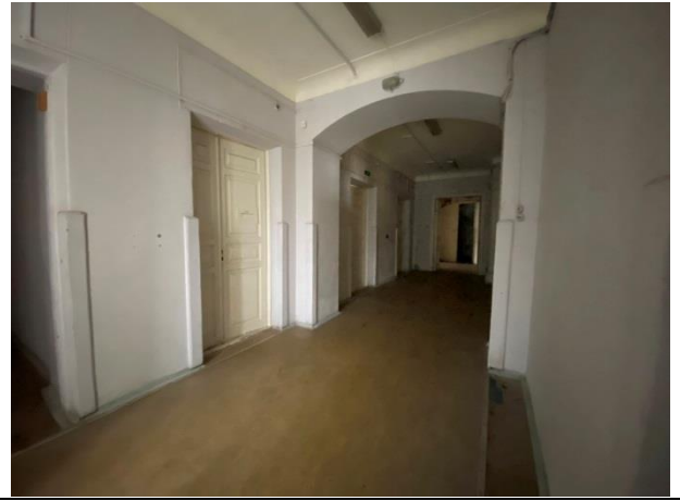
Фото № 24. Внутреннее состояние здания
