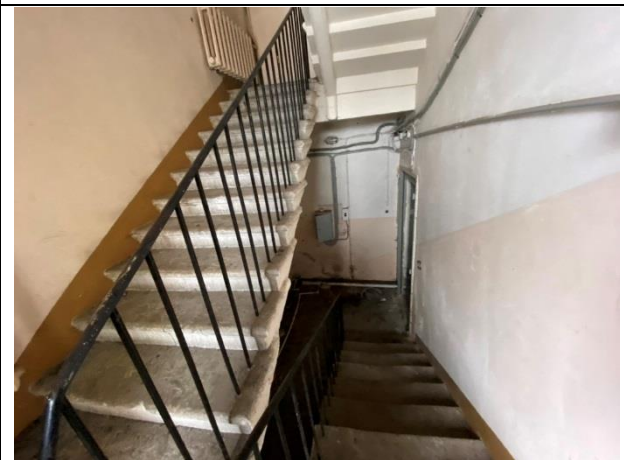
Фото № 13. Внутреннее состояние здания
