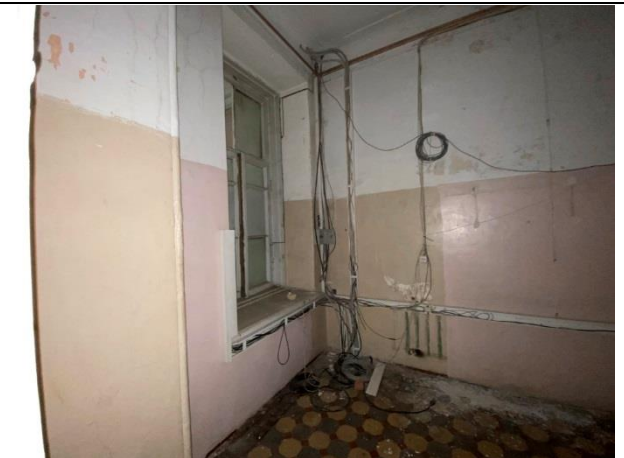
Фото № 36. Внутреннее состояние здания
