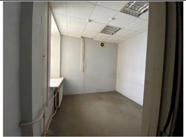
Фото № 42. Внутреннее состояние здания
