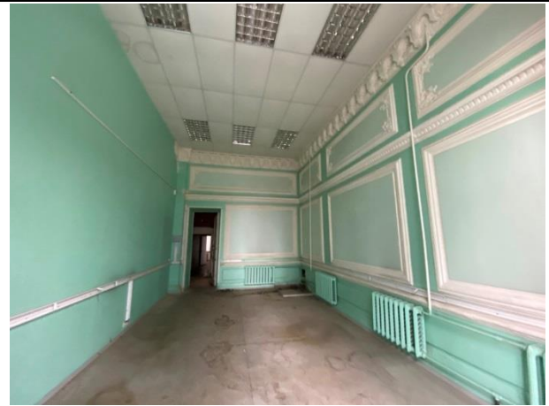
Фото № 41. Внутреннее состояние здания
