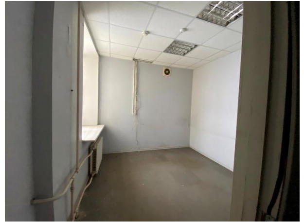
Фото № 42. Внутреннее состояние здания
