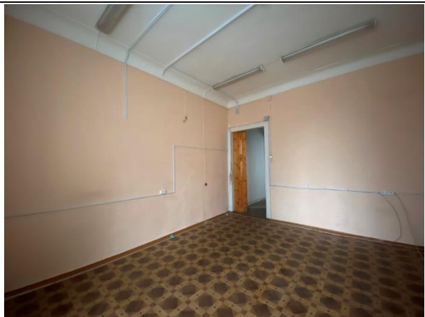
Фото № 29. Внутреннее состояние здания
