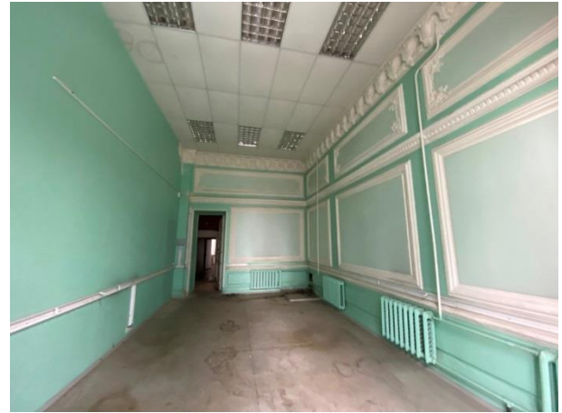
Фото № 41. Внутреннее состояние здания
