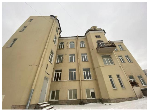
Фото № 10. Внешний вид здания
