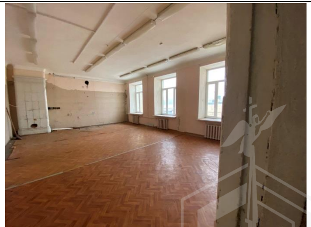
Фото № 16. Внутреннее состояние здания
