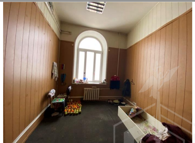
Фото № 38. Внутреннее состояние здания
