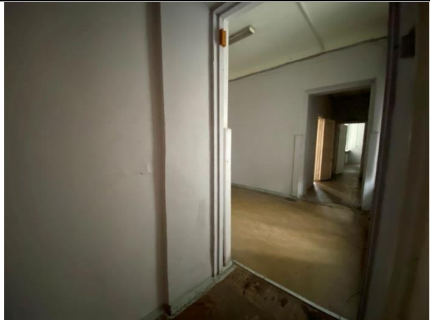
Фото № 27. Внутреннее состояние здания
