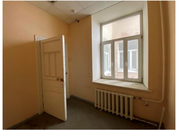
Фото № 26. Внутреннее состояние здания
