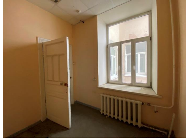
Фото № 26. Внутреннее состояние здания
