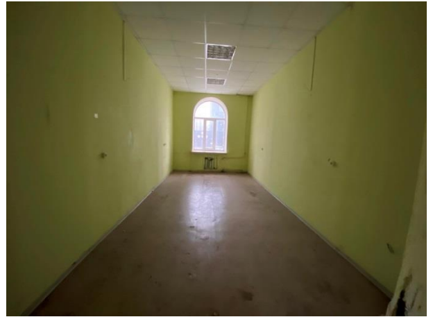
Фото № 34. Внутреннее состояние здания
