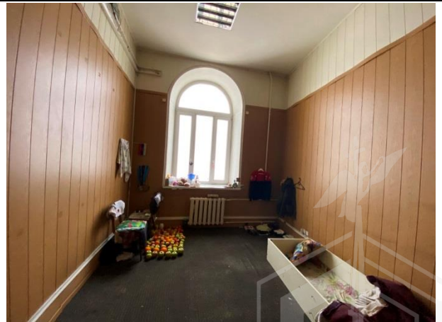
Фото № 38. Внутреннее состояние здания
