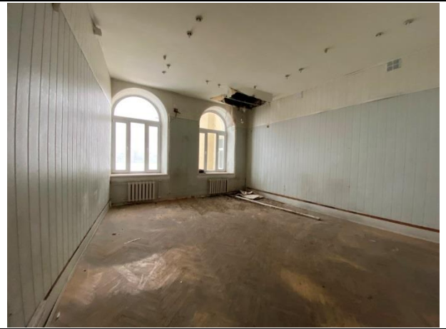
Фото № 40. Внутреннее состояние здания
