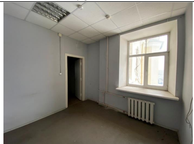
Фото № 43. Внутреннее состояние здания
