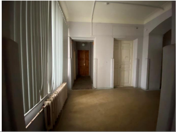
Фото № 23. Внутреннее состояние здания
