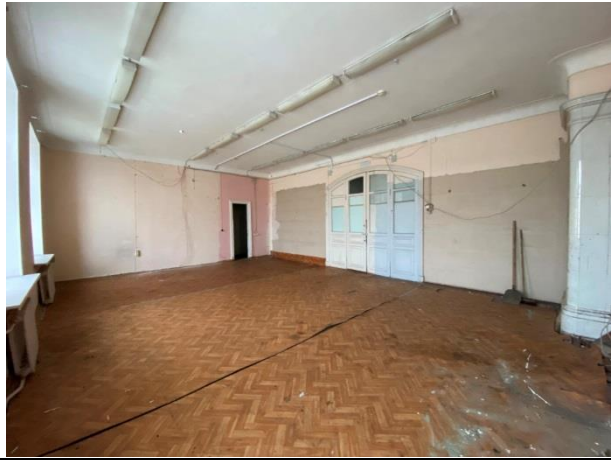
Фото № 17. Внутреннее состояние здания
