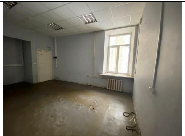
Фото № 14. Внутреннее состояние здания
