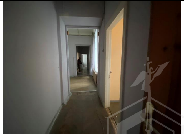
Фото № 30. Внутреннее состояние здания
