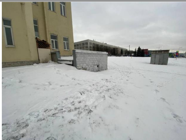
Фото № 7. Внешний вид земельного участка и здания
