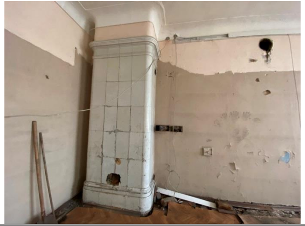
Фото № 18. Внутреннее состояние здания
