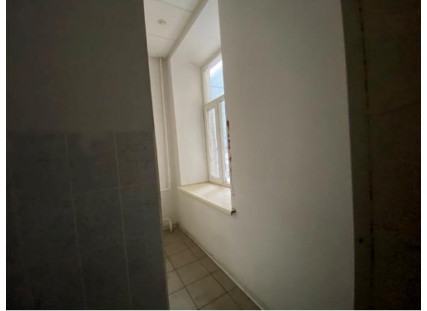
Фото № 20. Внутреннее состояние здания
