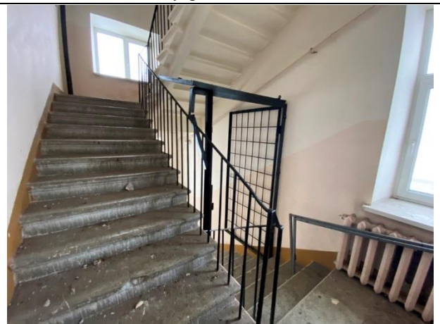
Фото № 44. Внутреннее состояние здания
