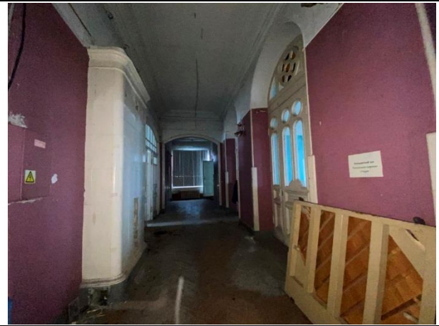
Фото № 39. Внутреннее состояние здания
