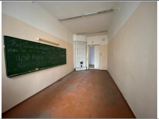
Фото № 31. Внутреннее состояние здания
