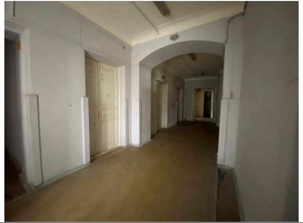
Фото № 24. Внутреннее состояние здания
