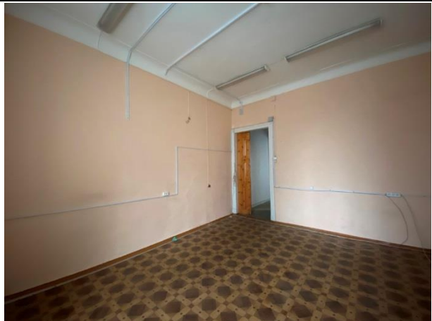
Фото № 29. Внутреннее состояние здания
