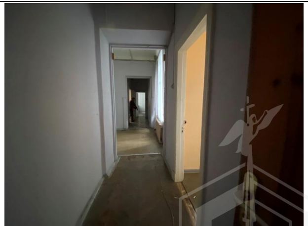
Фото № 30. Внутреннее состояние здания
