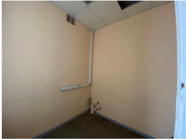
Фото № 25. Внутреннее состояние здания
