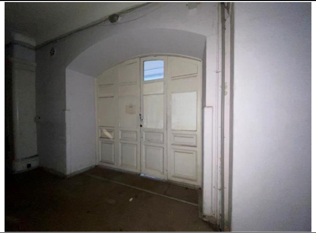
Фото № 32. Внутреннее состояние здания
