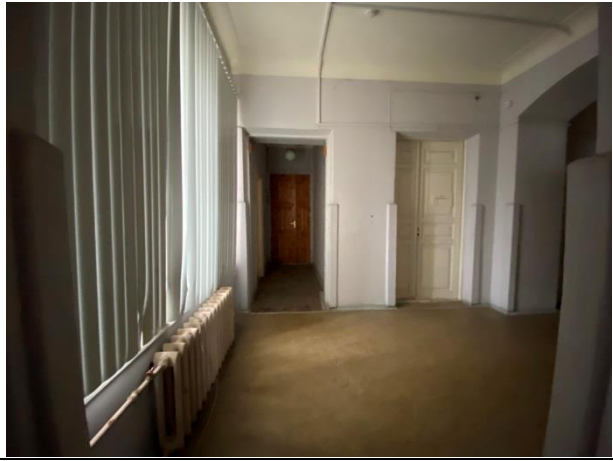
Фото № 23. Внутреннее состояние здания
