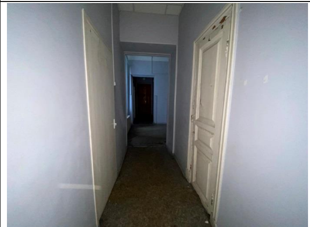
Фото № 15. Внутреннее состояние здания
