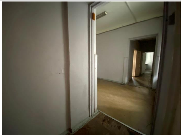
Фото № 27. Внутреннее состояние здания
