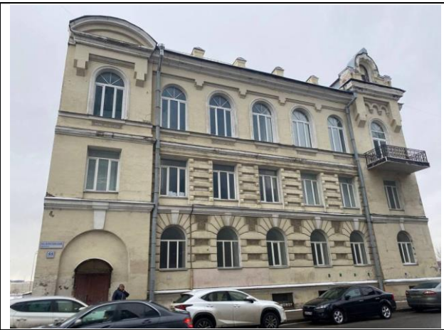
Фото № 9. Внешний вид здания
