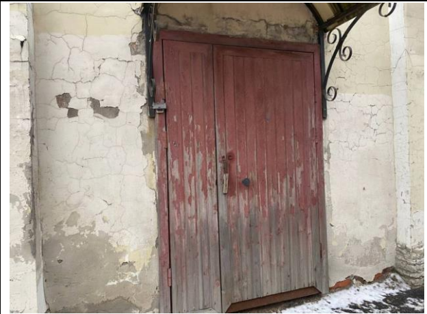
Фото № 11. Вход в здание
