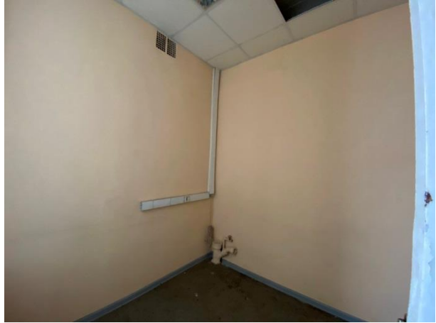
Фото № 25. Внутреннее состояние здания
