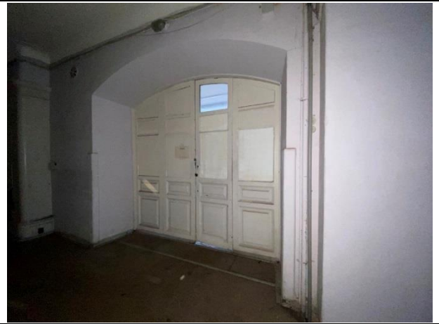
Фото № 32. Внутреннее состояние здания
