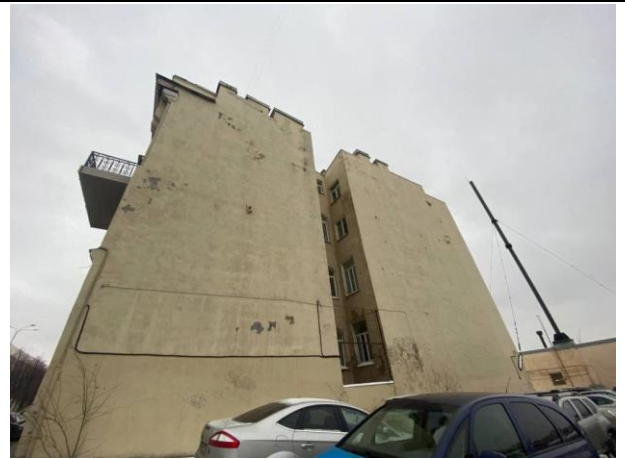
Фото № 12. Внешний вид здания
