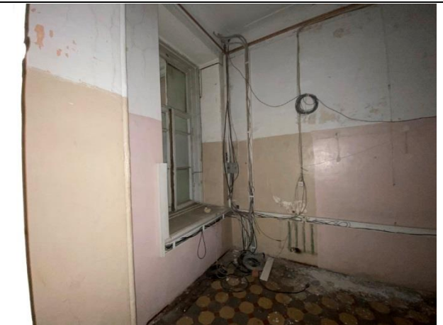
Фото № 36. Внутреннее состояние здания
