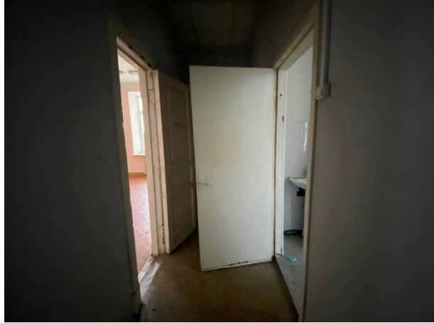
Фото № 19. Внутреннее состояние здания
