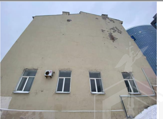
Фото № 8. Внешний вид здания
