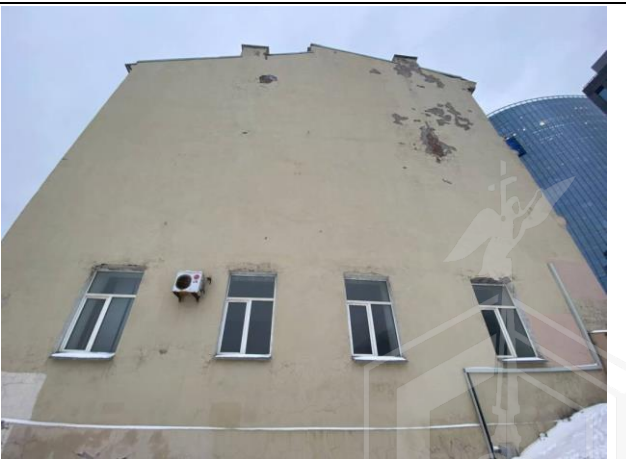
Фото № 8. Внешний вид здания
