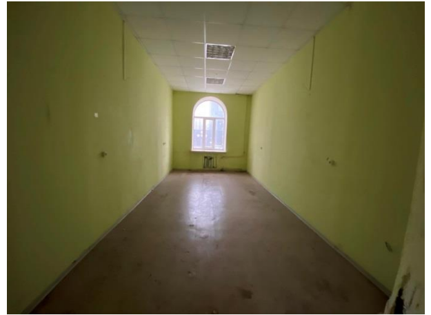
Фото № 34. Внутреннее состояние здания
