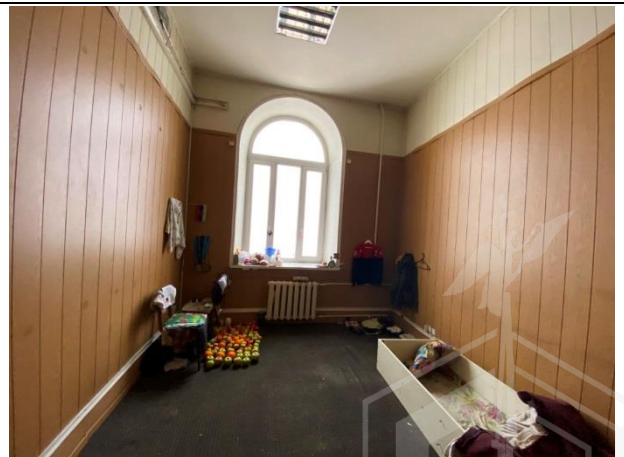
Фото № 38. Внутреннее состояние здания
