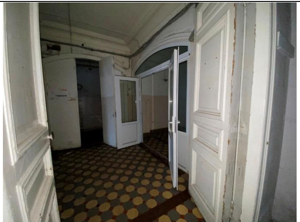
Фото № 35. Внутреннее состояние здания
