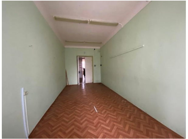
Фото № 33. Внутреннее состояние здания
