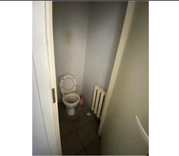
Фото № 21. Внутреннее состояние здания
