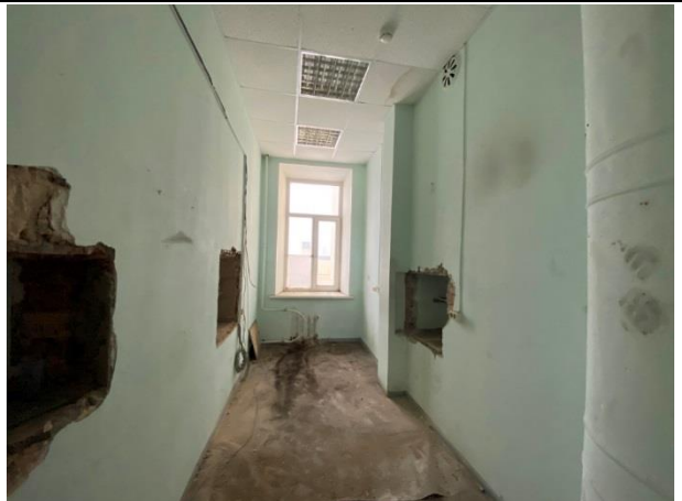
Фото № 37. Внутреннее состояние здания
