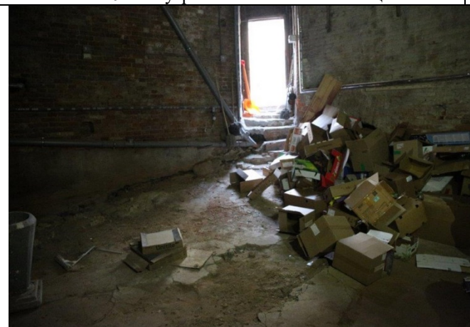
Фото № 11 – Внутреннее состояние помещения
