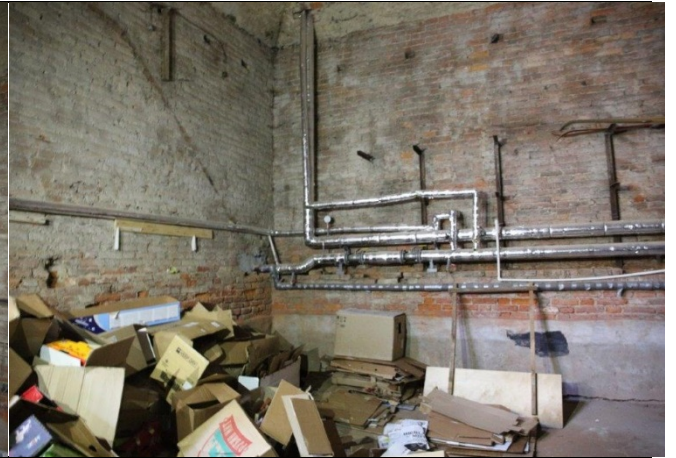
Фото № 8 – Внутреннее состояние помещения
