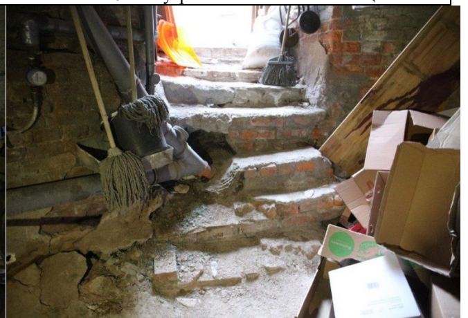
Фото № 12 – Внутреннее состояние помещения
