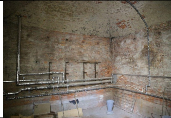
Фото № 7 – Внутреннее состояние помещения
