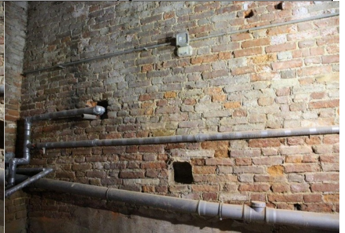
Фото № 10 – Внутреннее состояние помещения
