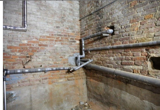
Фото № 9 – Внутреннее состояние помещения
