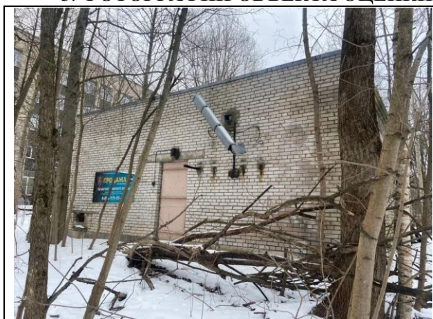
Фото № 1. Внешний вид здания
