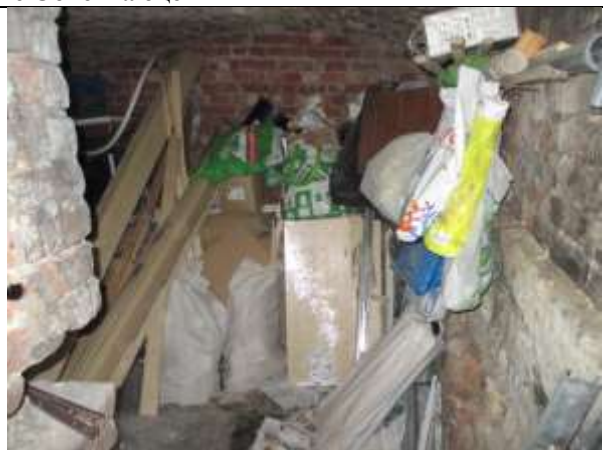
Фото 12. Внутреннее состояние Объекта оценки
