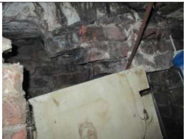
Фото 14. Внутреннее состояние Объекта оценки
