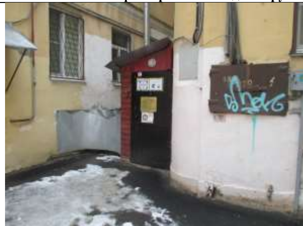
Фото 7. Доступ Объекта оценки (самовольная пристройка – общий вход с пом. 3-Н)
