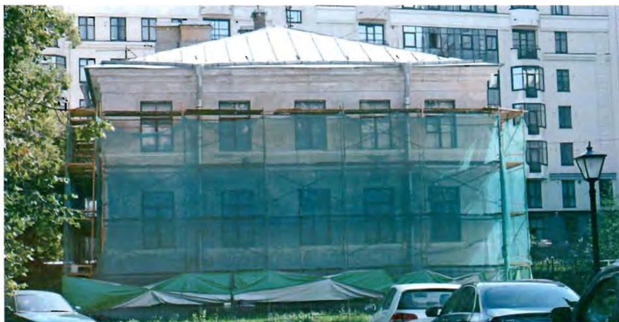
Фото №1. Вид на западный фасад со стороны сада.
