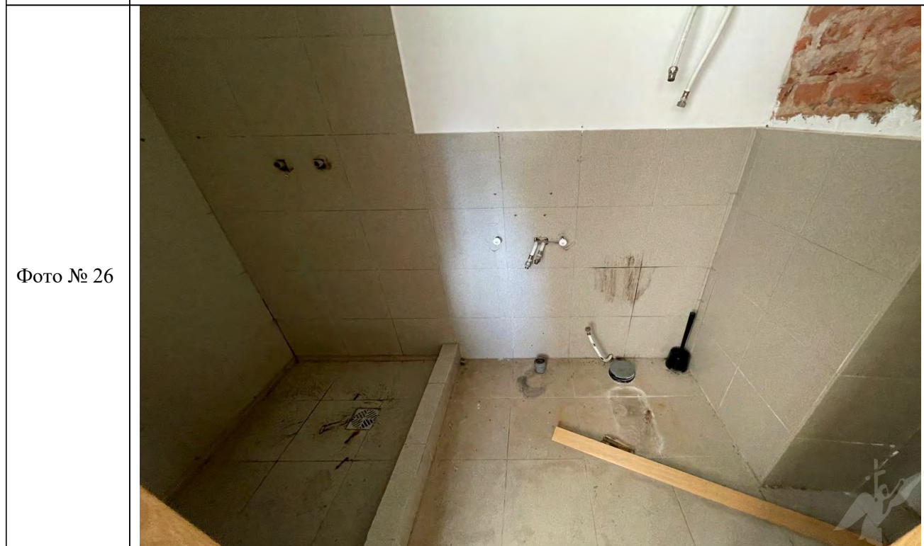
Описание: Ч.п. 13 Объекта демонтировано сантехническое оборудование (раковины)
