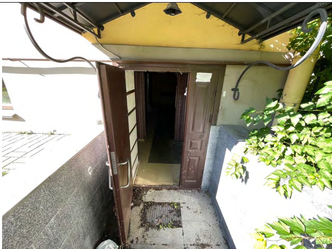
Описание: Вид на вход на Объект
