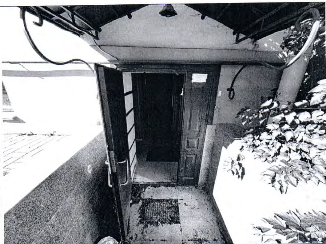
Описание: Вид на вход на Объект
