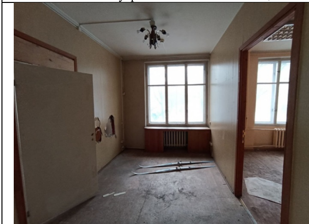
Фото № 13 – Внутреннее состояние помещения
