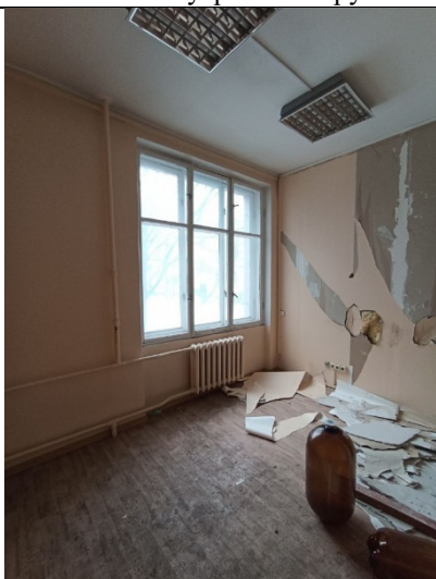
Фото № 7 – Внутреннее состояние помещения
