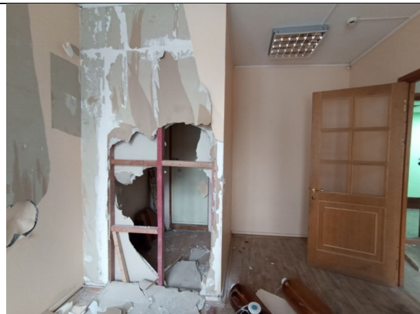
Фото № 12 – Внутреннее состояние помещения
