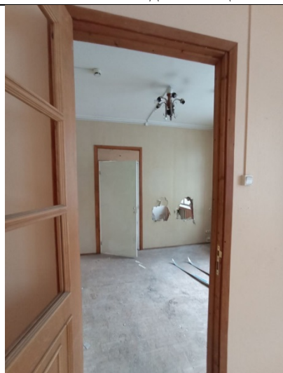
Фото № 8 – Внутреннее состояние помещения
