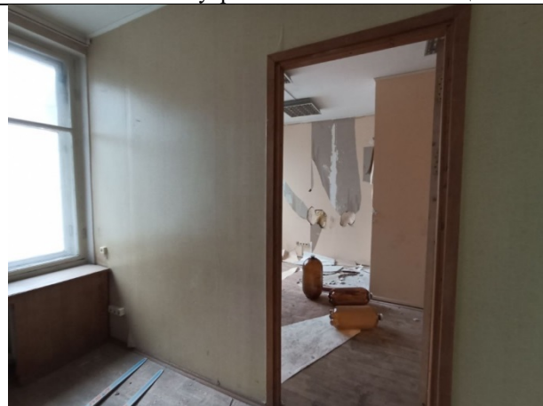
Фото № 14 – Внутреннее состояние помещения
