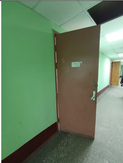
Фото № 7 – Вход в помещение
