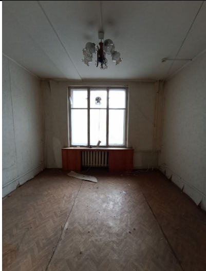
Фото № 9 – Внутреннее состояние помещения
