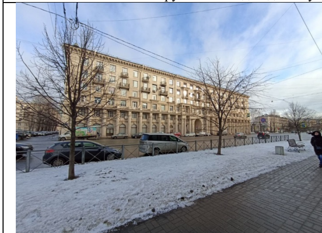
Фото № 3 – Здание, в котором находится Объект оценки
