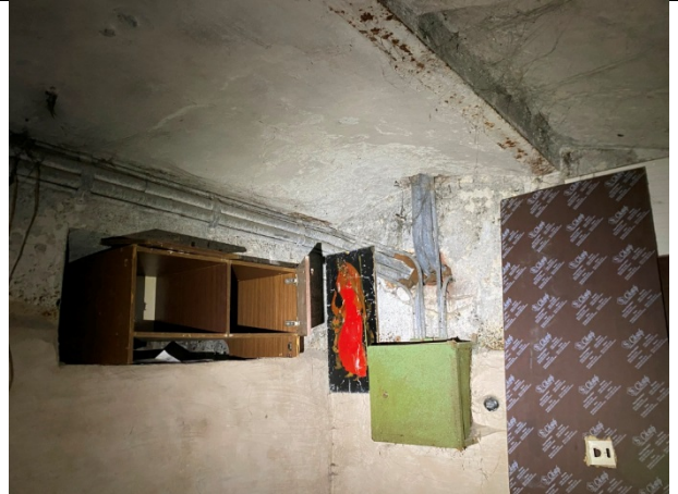
Фото № 12 – Внутреннее состояние помещения
