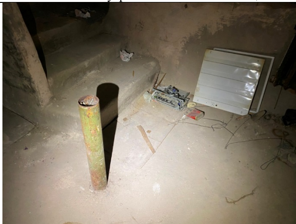
Фото № 13 – Внутреннее состояние помещения
