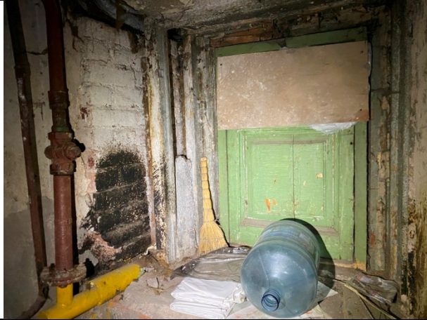
Фото № 9 – Внутреннее состояние помещения
