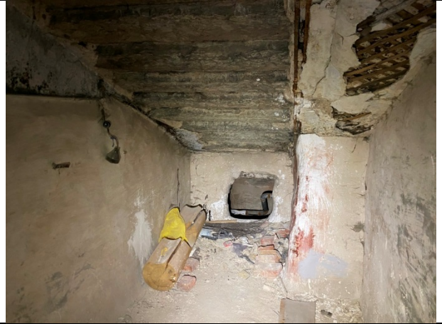
Фото № 10 – Внутреннее состояние помещения
