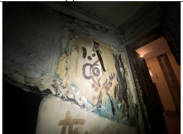
Фото № 14 – Внутреннее состояние помещения
