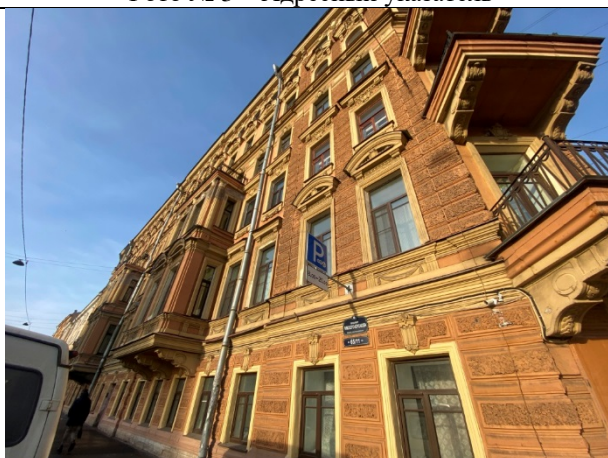
Фото № 5 – Здание, в котором расположен объект оценки
