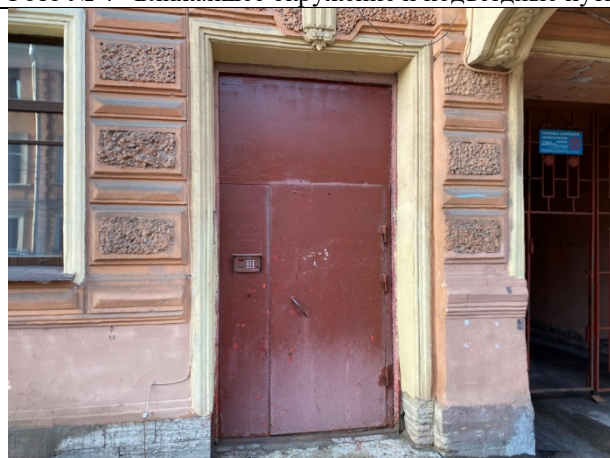
Фото № 6 – Вход в помещение
