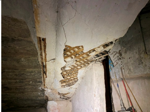
Фото № 11 – Внутреннее состояние помещения
