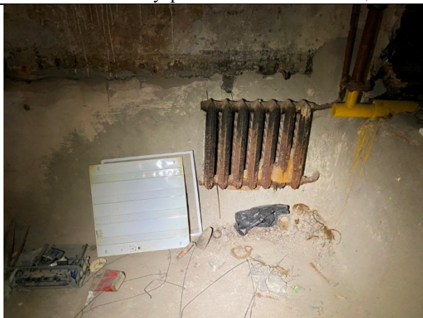
Фото № 15 – Внутреннее состояние помещения
