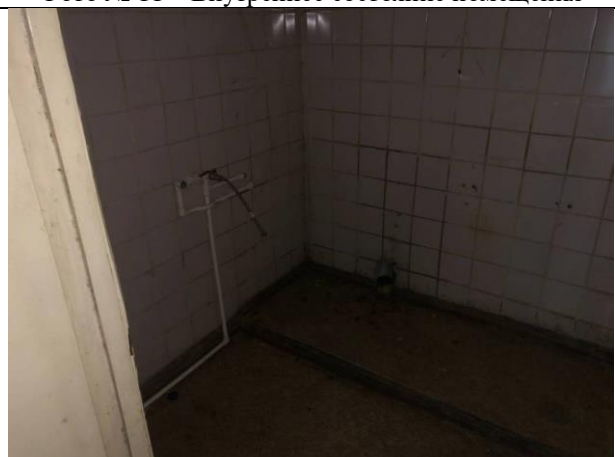
Фото № 13 – Внутреннее состояние помещения
