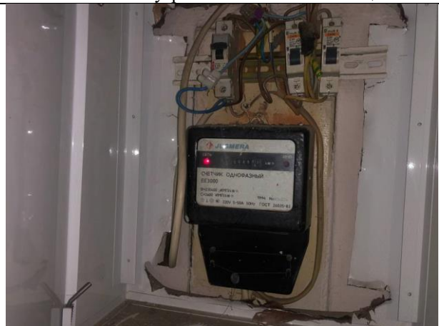
Фото № 9 – Внутреннее состояние помещения
