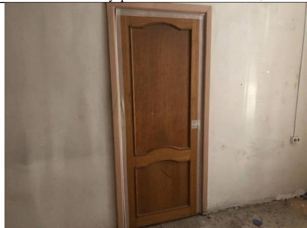
Фото № 10 – Внутреннее состояние помещения
