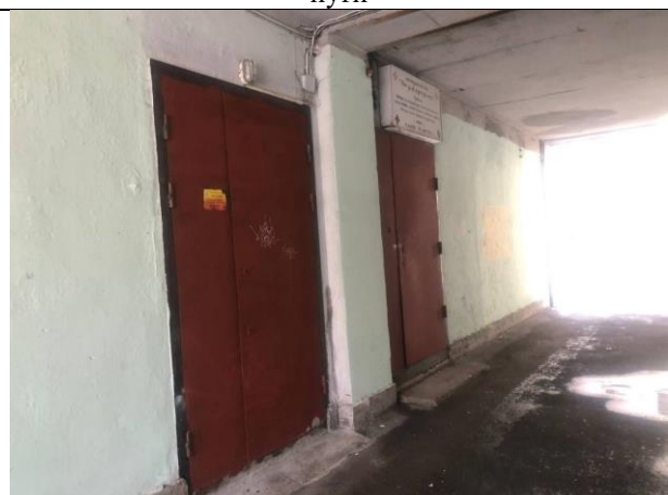
Фото № 4 – Вход в помещение из-под арки
