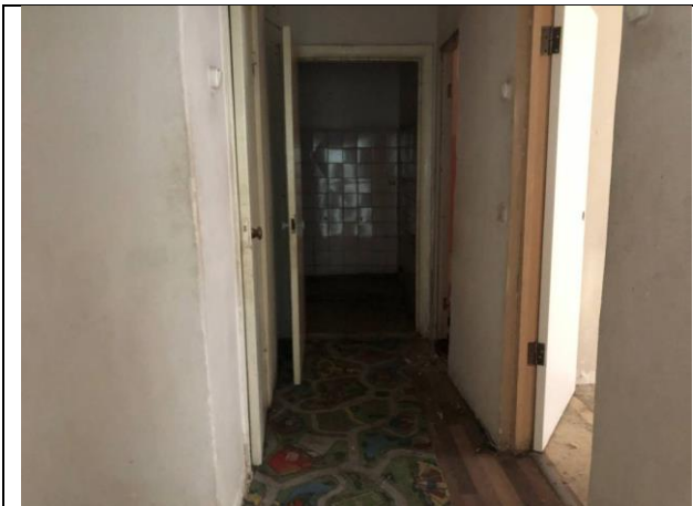
Фото № 7 – Внутреннее состояние помещения
