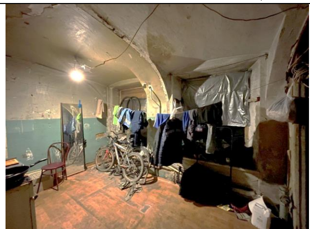
Фото 26. Типичное состояние Объекта оценки
