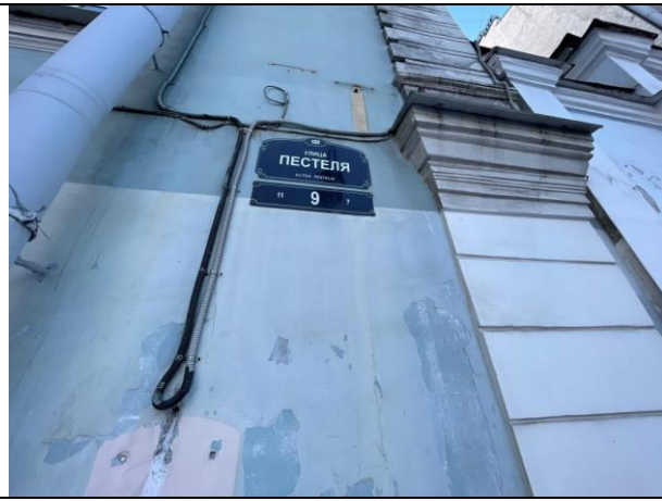
Фото 15. Адрес Объекта оценки
