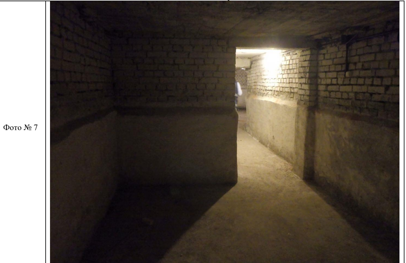
Описание: ч.п. 1 вид внутри Объекта
