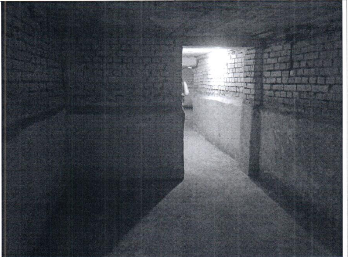
Описание: ч.п. 1 вид внутри Объекта
