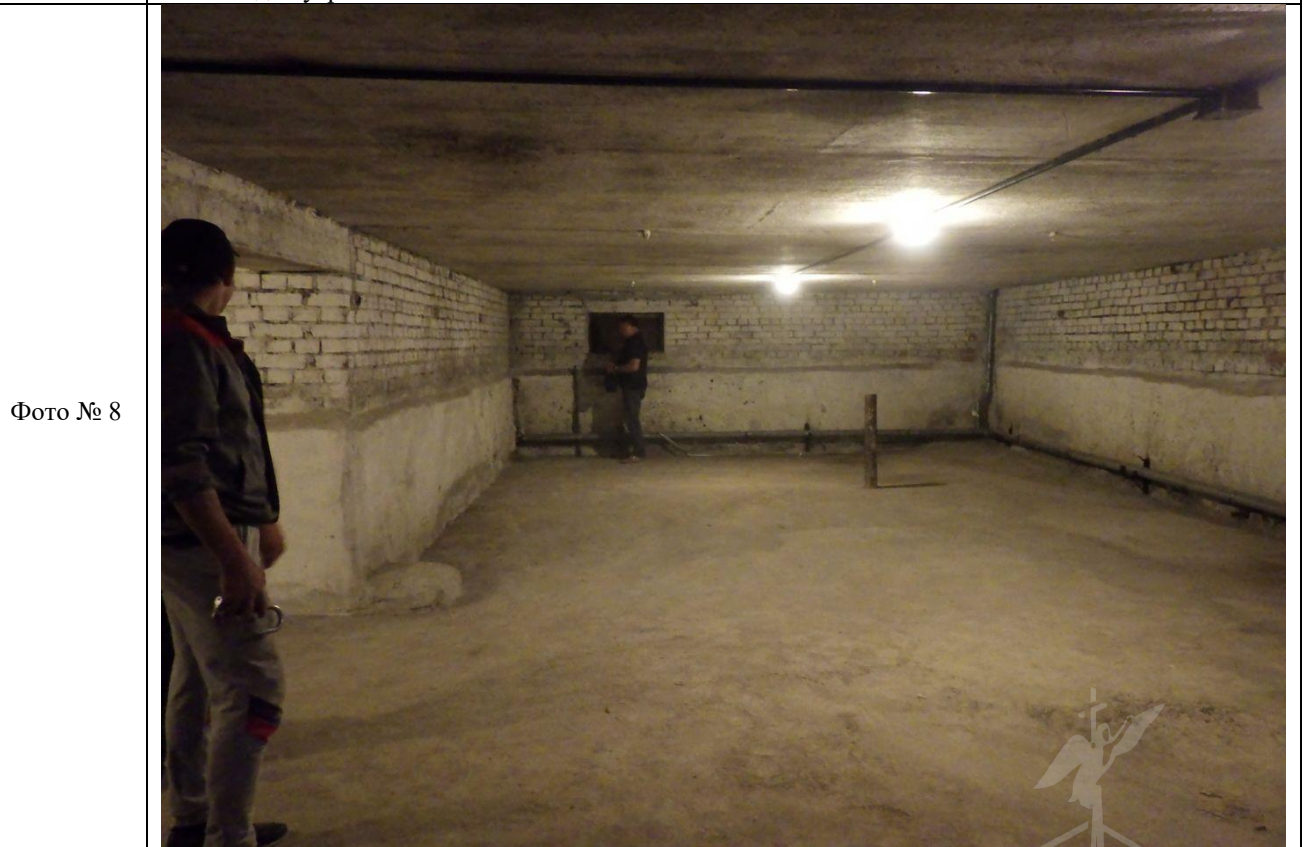
Описание: ч.п. 4 вид внутри Объекта
