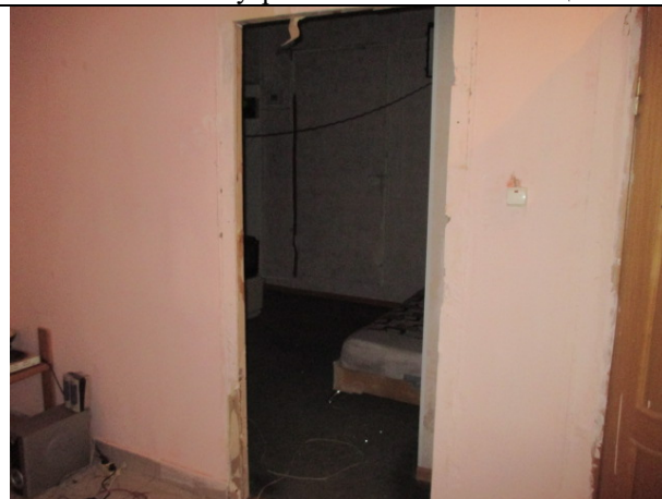
Фото № 10 – Внутреннее состояние помещения
