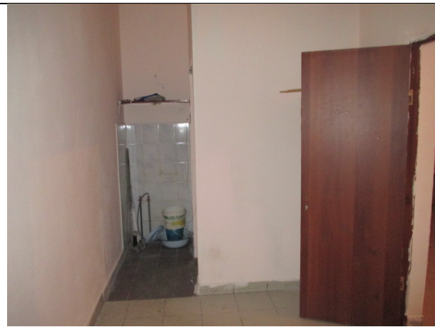
Фото № 14 – Внутреннее состояние помещения
