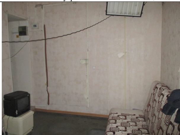
Фото № 11 – Внутреннее состояние помещения
