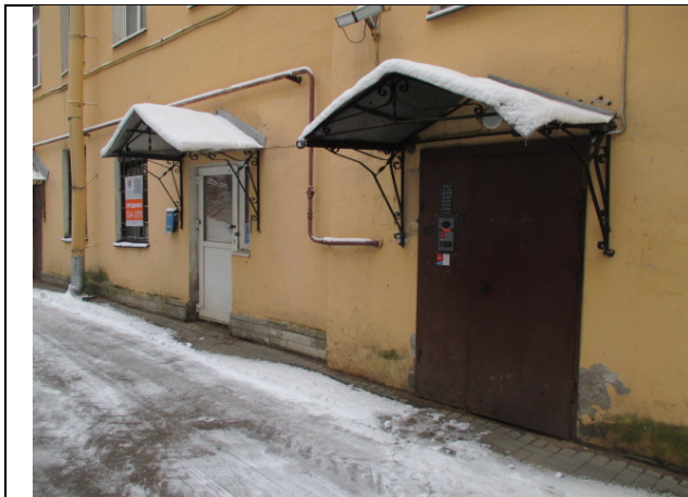
Фото № 5 – Общий вход в помещение
