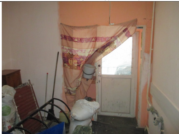
Фото № 7 – Внутреннее состояние помещения
