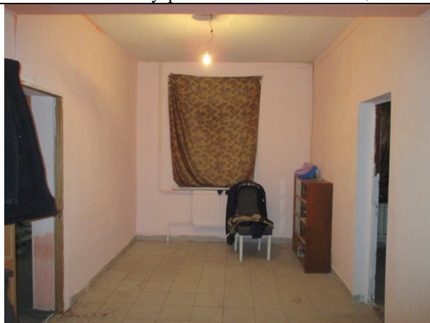
Фото № 9 – Внутреннее состояние помещения
