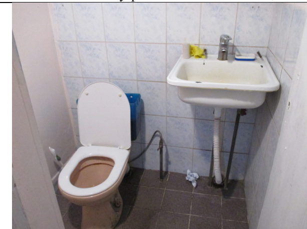
Фото № 16 – Внутреннее состояние помещения
