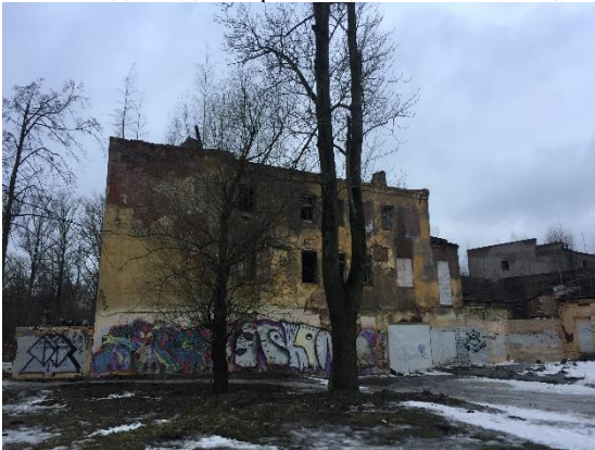
Фото 5. Вид на здание размещения Объекта оценки.
