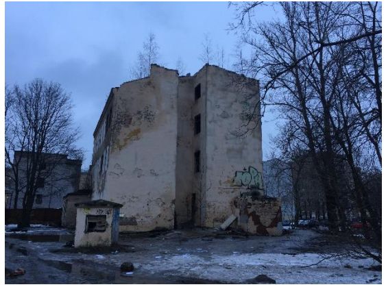
Фото 2. Вид на здание размещения Объекта оценки.
