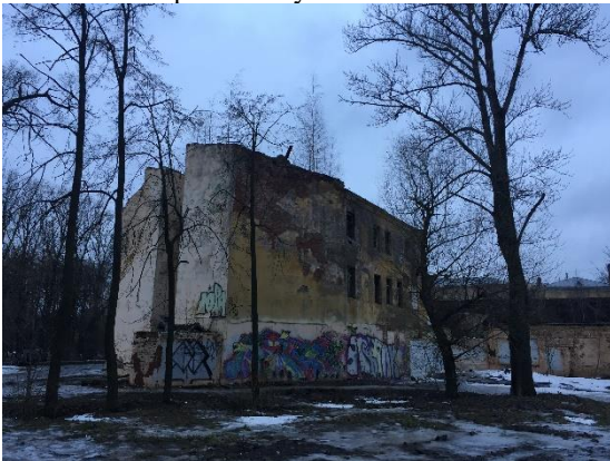
Фото 3. Вид на здание размещения Объекта оценки.
