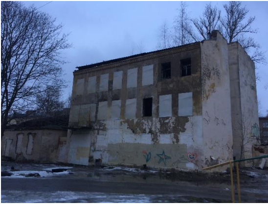
Фото 1. Вид на здание размещения Объекта оценки с набережной Бумажного канала.
