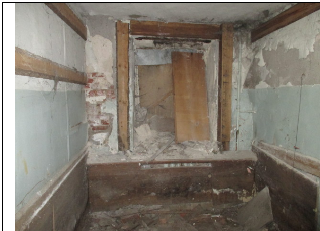
Фото № 13 – Внутреннее состояние помещения
