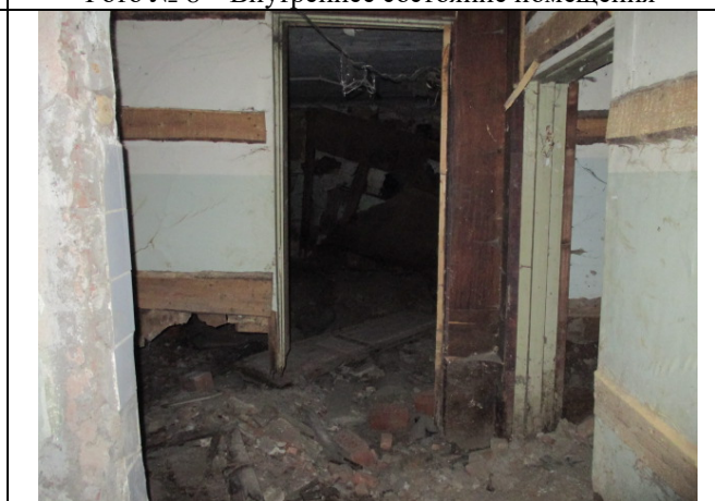
Фото № 10 – Внутреннее состояние помещения
