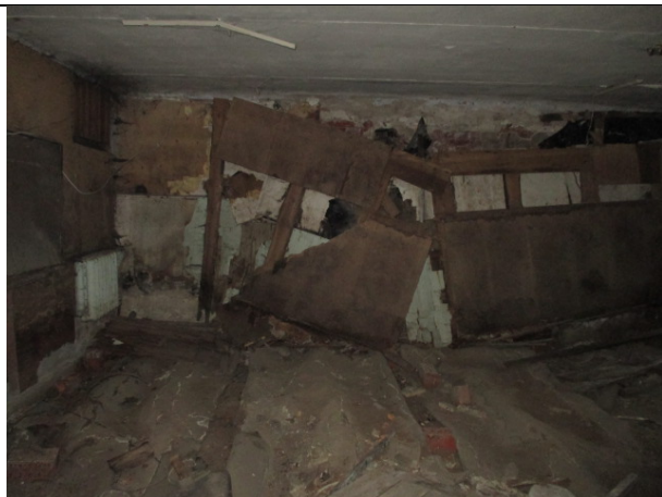
Фото № 14 – Внутреннее состояние помещения
