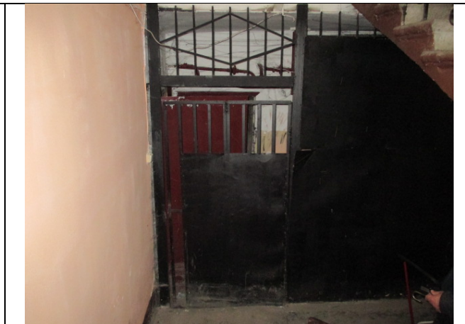
Фото № 6 – Проход к помещению
