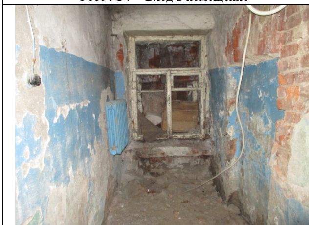
Фото № 9 – Внутреннее состояние помещения
