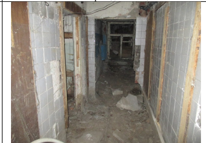
Фото № 8 – Внутреннее состояние помещения
