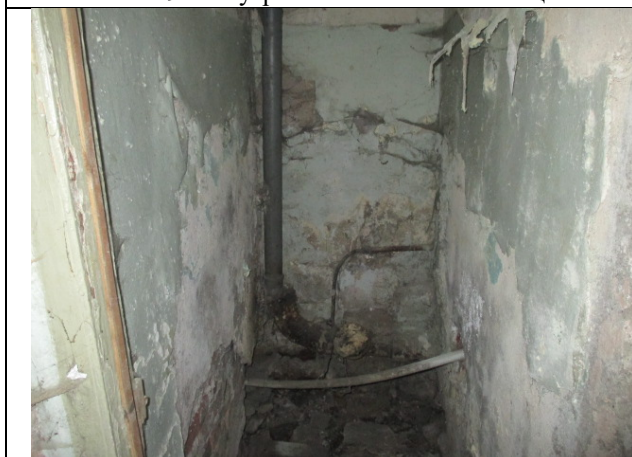
Фото № 11 – Внутреннее состояние помещения
