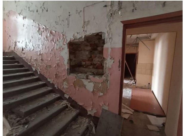
Фото № 20. Внутреннее состояние здания
