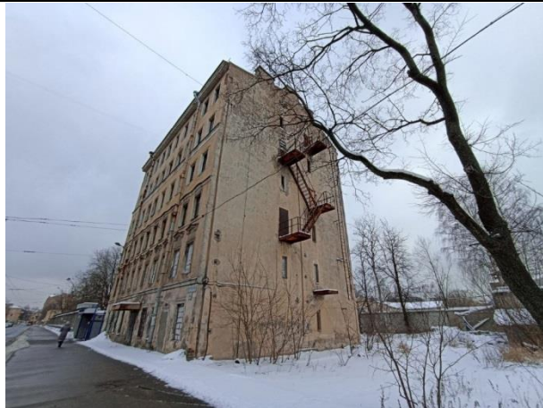
Фото № 3. Внешний вид здания (литера А)
