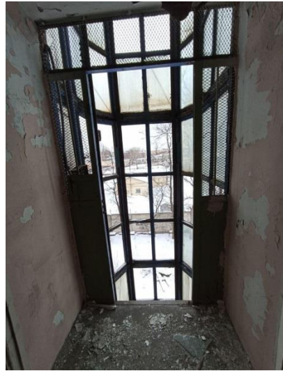
Фото № 22. Внутреннее состояние здания
