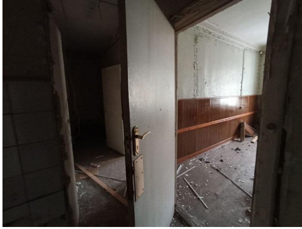
Фото № 15. Внутреннее состояние здания
