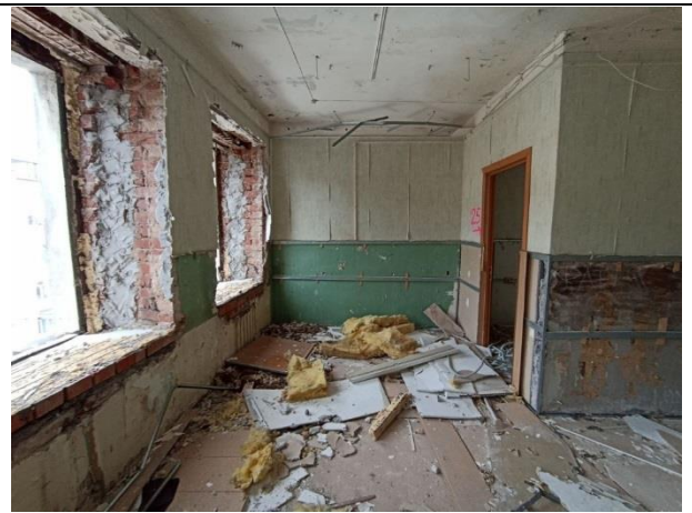
Фото № 12. Внутреннее состояние здания
