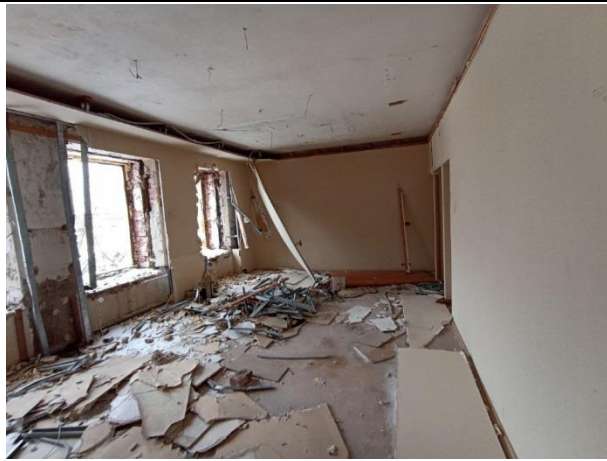
Фото № 7. Внутреннее состояние здания
