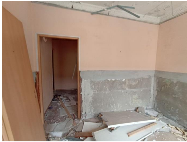
Фото № 9. Внутреннее состояние здания
