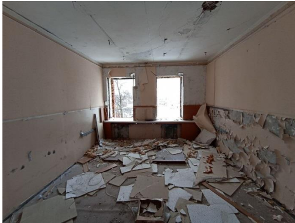
Фото № 17. Внутреннее состояние здания
