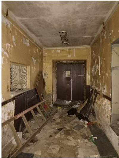
Фото № 21. Внутреннее состояние здания
