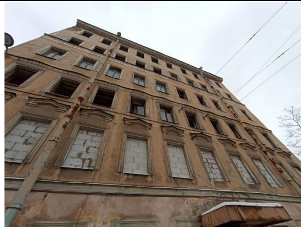
Фото № 4. Внешний вид здания (литера А)
