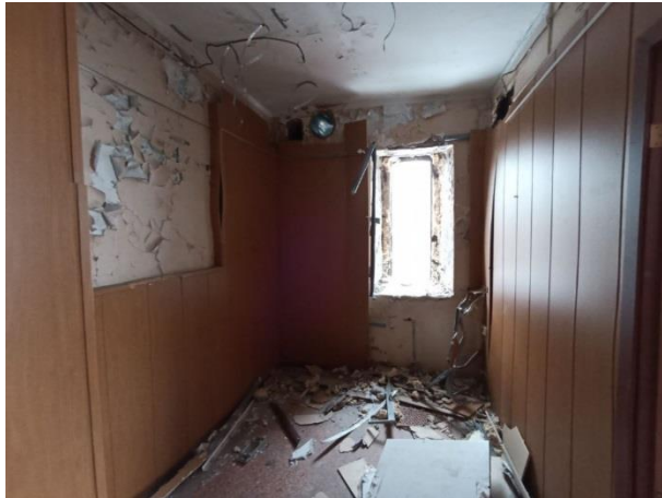
Фото № 19. Внутреннее состояние здания
