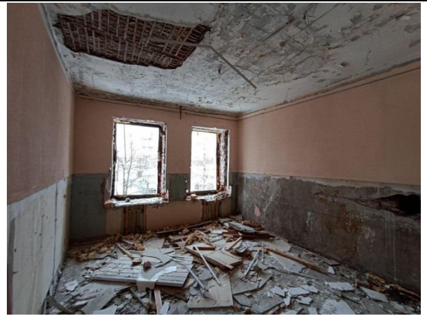
Фото № 8. Внутреннее состояние здания
