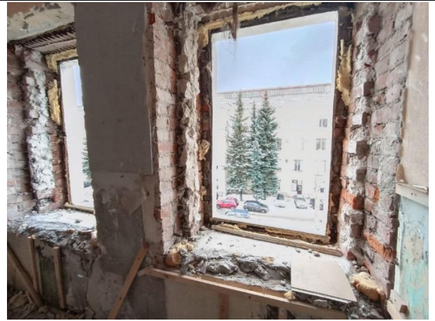
Фото № 10. Внутреннее состояние здания
