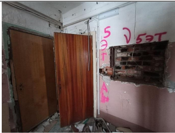
Фото № 11. Внутреннее состояние здания
