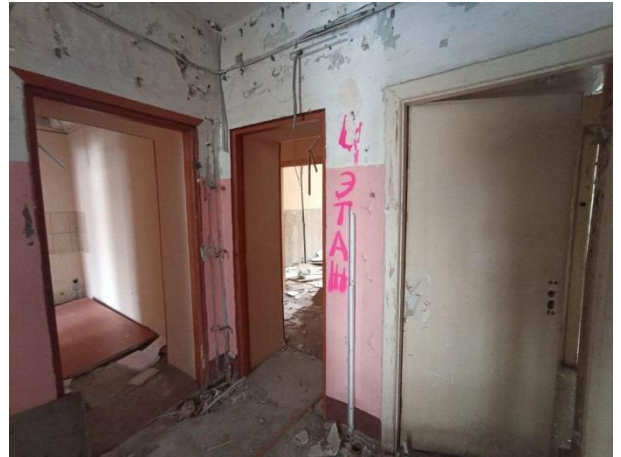
Фото № 18. Внутреннее состояние здания
