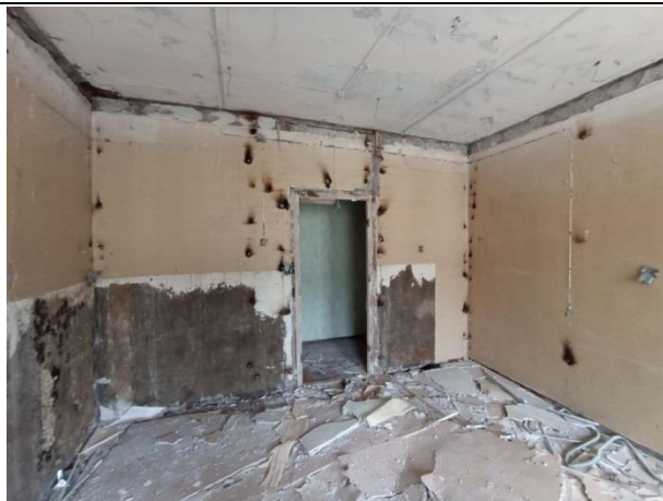
Фото № 13. Внутреннее состояние здания
