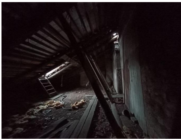
Фото № 23. Внутреннее состояние здания
