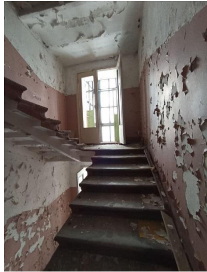
Фото № 16. Внутреннее состояние здания
