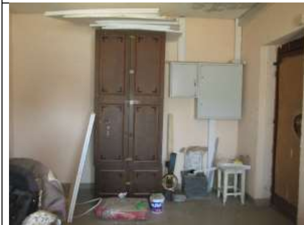
Фото 13. Внутреннее состояние Объекта оценки
