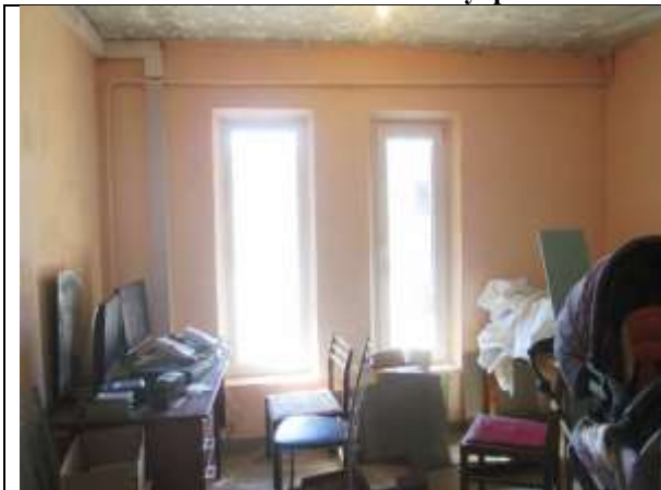
Фото 11. Внутреннее состояние Объекта оценки
