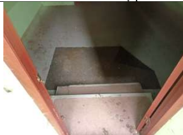
Фото 7. Внутреннее состояние Объекта оценки
