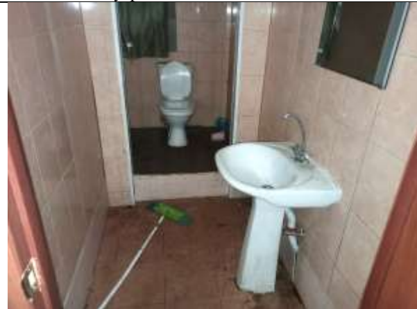
Фото 11. Внутреннее состояние Объекта оценки
