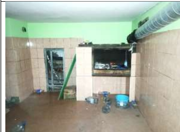
Фото 17. Внутреннее состояние Объекта оценки
