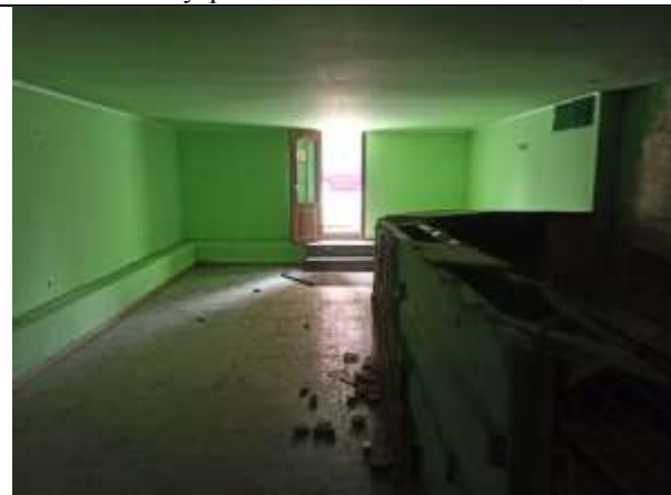
Фото 10. Внутреннее состояние Объекта оценки
