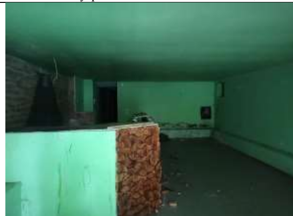
Фото 9. Внутреннее состояние Объекта оценки
