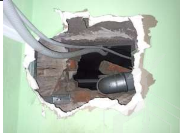
Фото 14. Внутреннее состояние Объекта оценки
