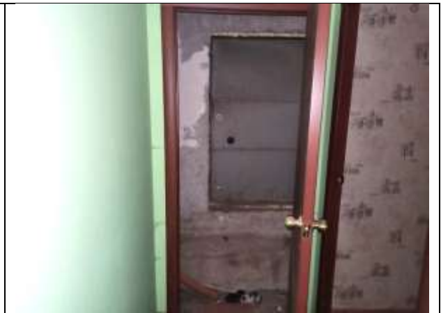
Фото 16. Внутреннее состояние Объекта оценки (проход в подвал из ч.п. 2)
