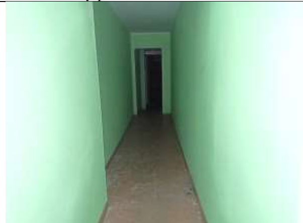
Фото 12. Внутреннее состояние Объекта оценки
