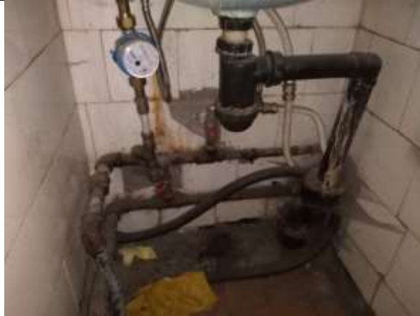
Фото 21. Внутреннее состояние Объекта оценки
