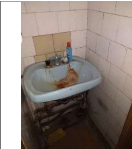
Фото 19. Внутреннее состояние Объекта оценки
