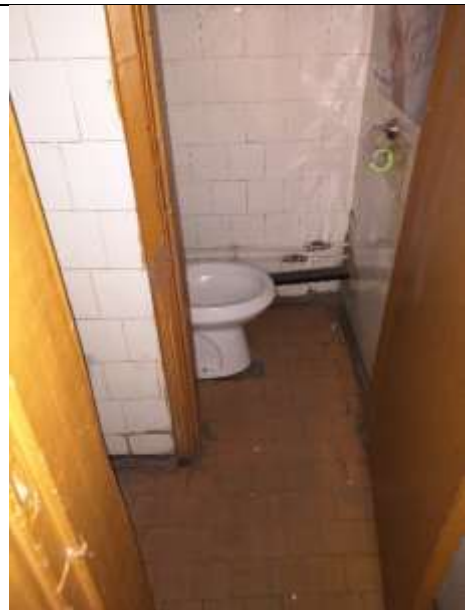
Фото 20. Внутреннее состояние Объекта оценки
