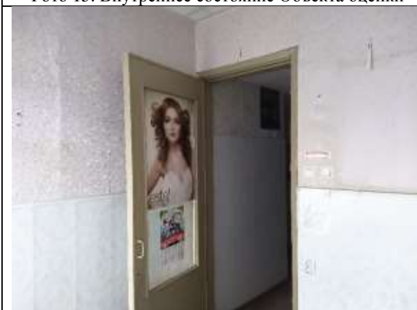
Фото 17. Внутреннее состояние Объекта оценки
