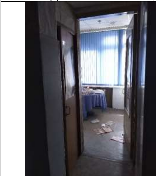
Фото 11. Внутреннее состояние Объекта оценки
