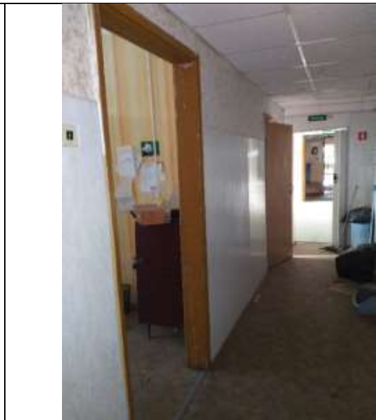
Фото 26. Внутреннее состояние Объекта оценки
