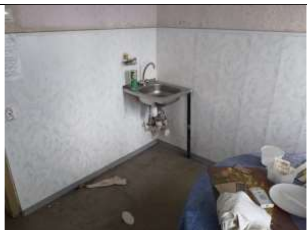
Фото 14. Внутреннее состояние Объекта оценки
