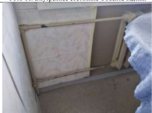
Фото 18. Внутреннее состояние Объекта оценки
