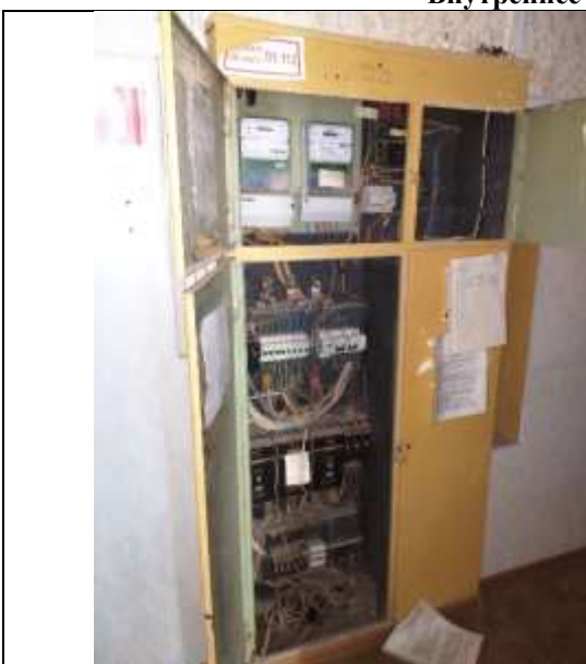
Фото 9. Внутреннее состояние Объекта оценки
