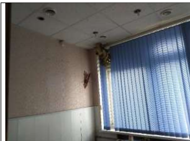
Фото 13. Внутреннее состояние Объекта оценки
