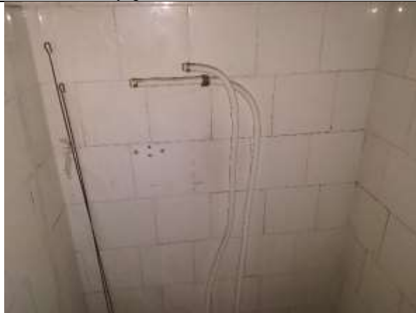
Фото 23. Внутреннее состояние Объекта оценки
