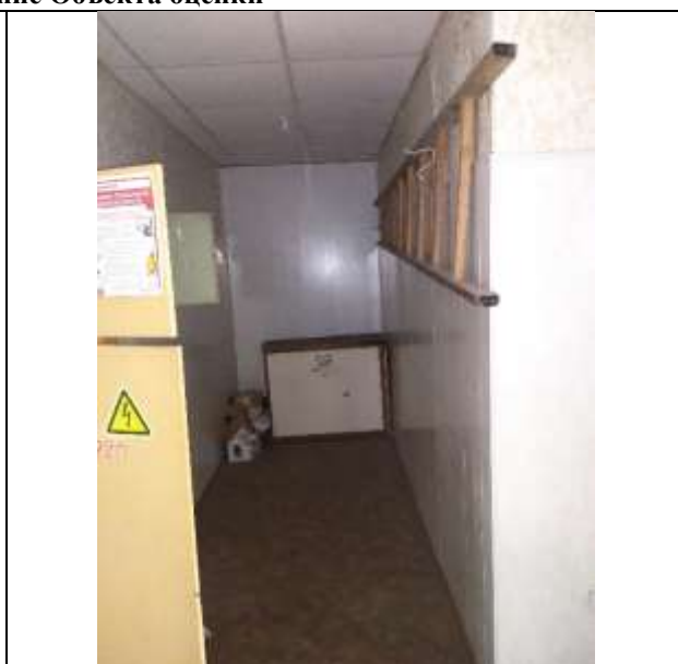
Фото 10. Внутреннее состояние Объекта оценки
