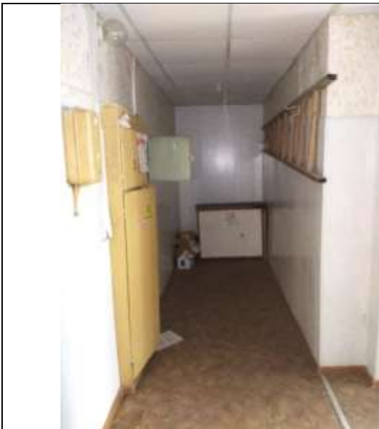
Фото 25. Внутреннее состояние Объекта оценки
