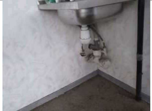
Фото 22. Внутреннее состояние Объекта оценки
