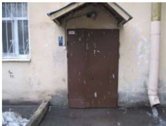
Фото 10. Общий вход со двора
