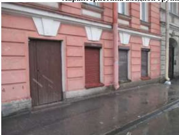
Фото 7. Отдельный вход с улицы и окна Объекта оценки
