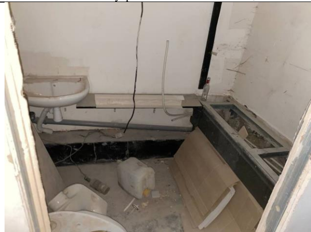
Фото № 10 – Внутреннее состояние помещения
