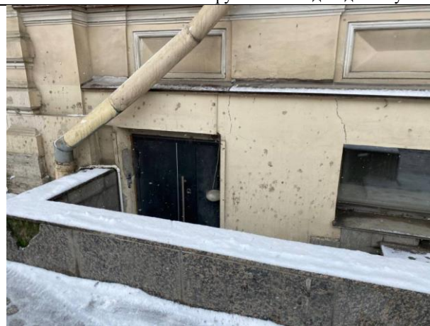
Фото № 4 – Вход в помещение с улицы
