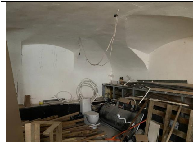
Фото № 7 – Внутреннее состояние помещения
