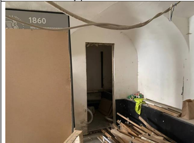
Фото № 9 – Внутреннее состояние помещения
