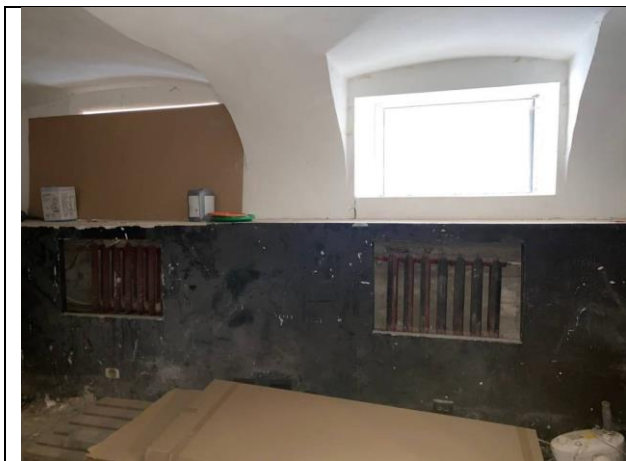
Фото № 15 – Внутреннее состояние помещения
