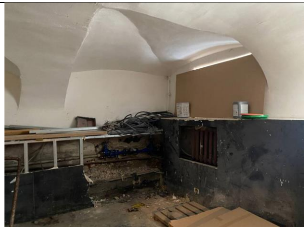
Фото № 8 – Внутреннее состояние помещения
