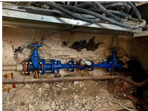
Фото № 16 – Внутреннее состояние помещения
