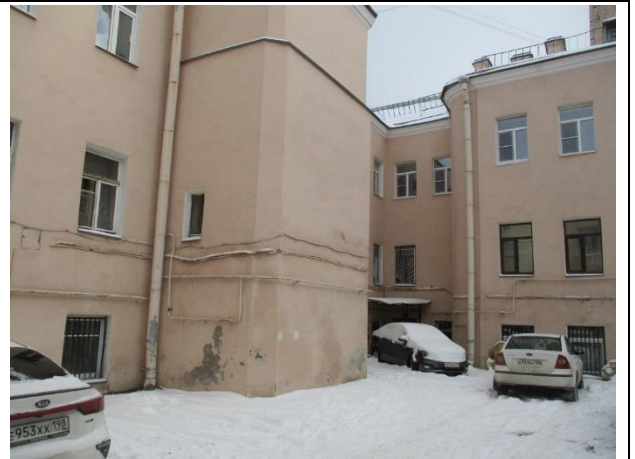
Фото 6 Фасад здания со двора
