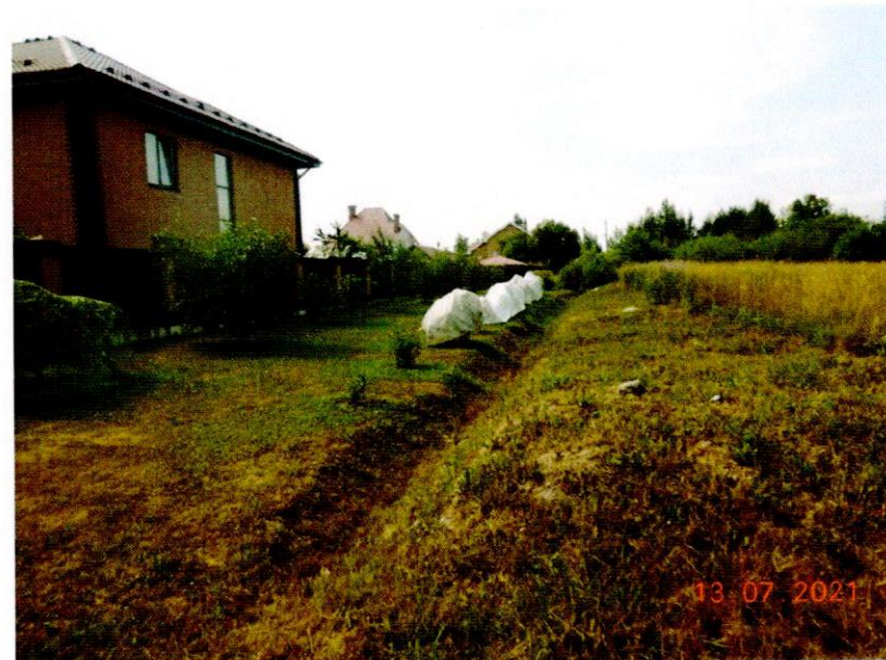
Фото №6. Водоотводная канава.
