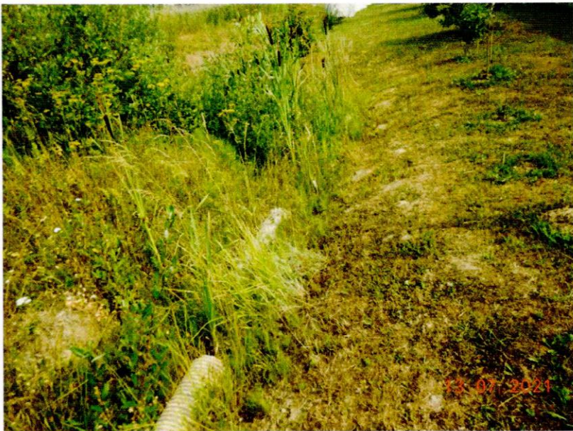
Фото №5. Водоотводная канава.
