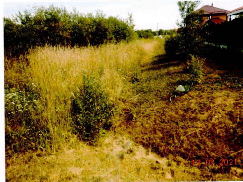
Фото №4. Водоотводная канава.
