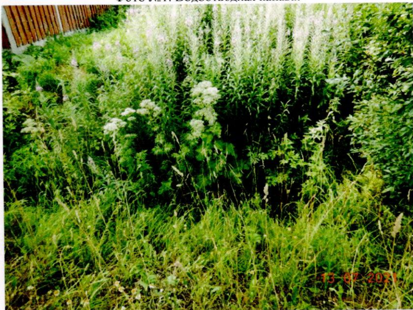
Фото №3. Впадение водоотводной канавы.
