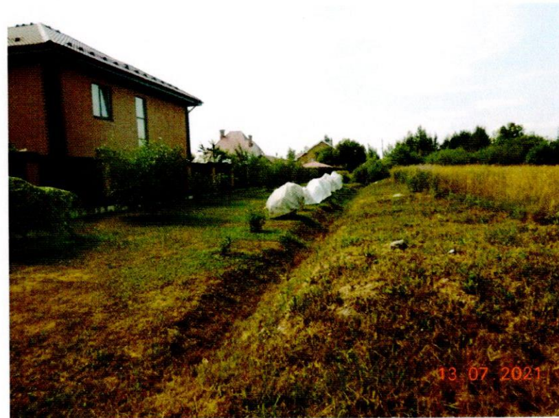
Фото №6. Водоотводная канава.
