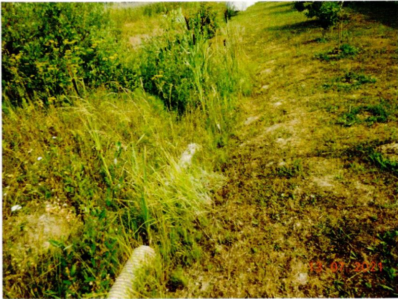
Фото №5. Водоотводная канава.
