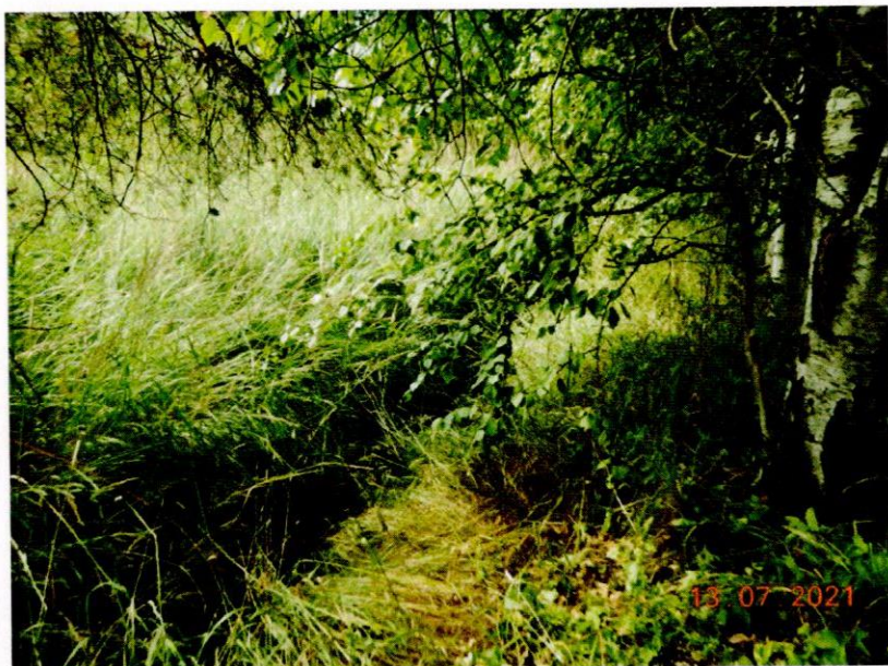
Фото №1. Водоотводная канава.
