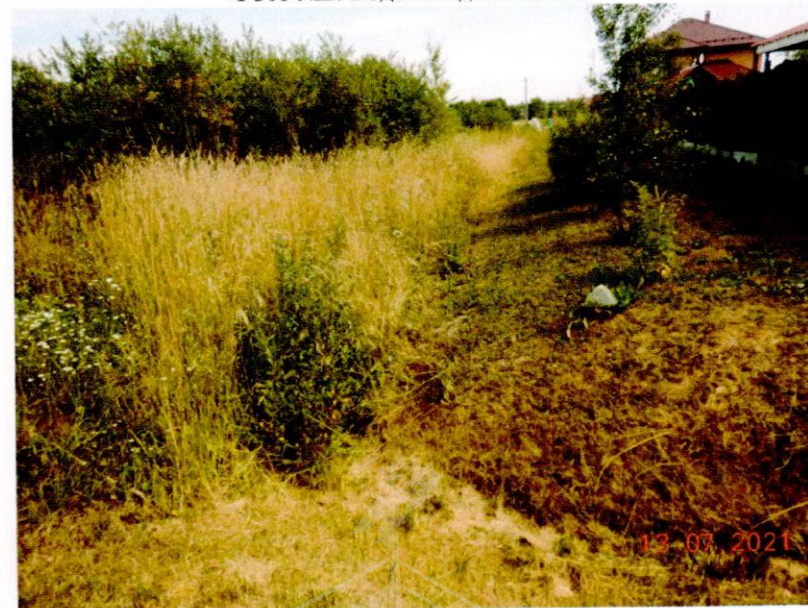
Фото №4. Водоотводная канава.
