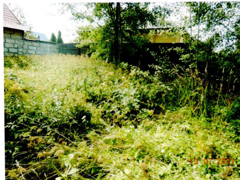
Фото №2. Водоотводная канава.
