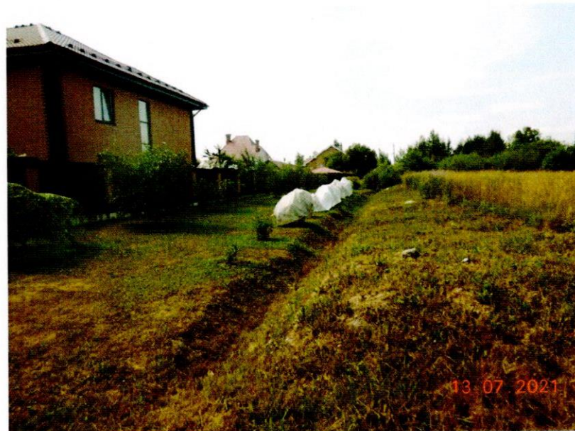
Фото №6. Водоотводная канава.
