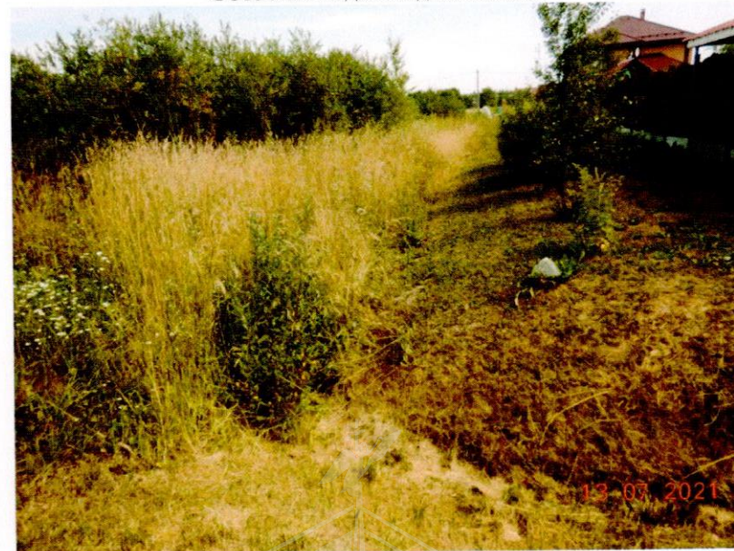
Фото №4. Водоотводная канава.
