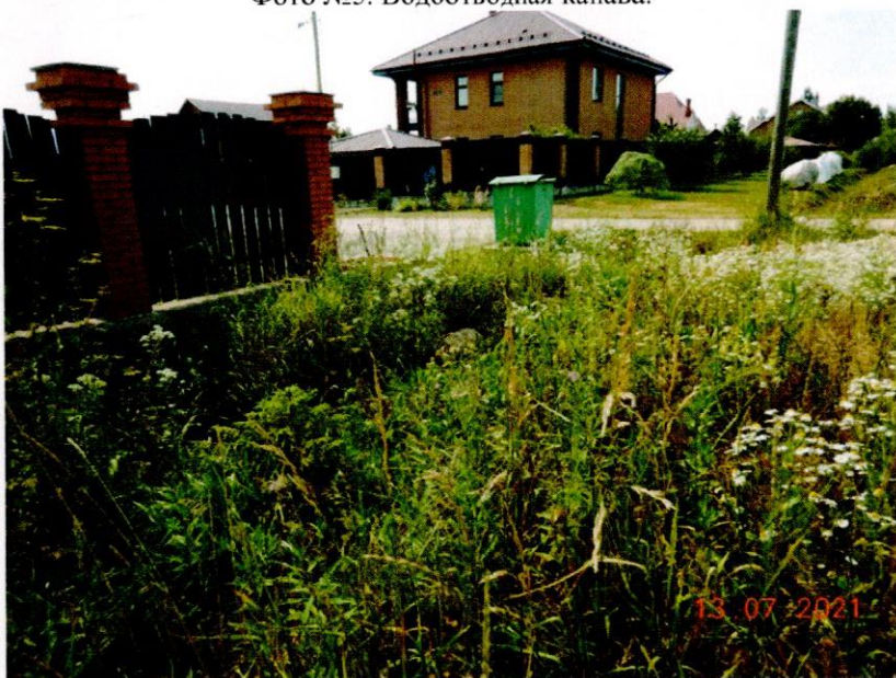
Фото №7. Водоотводная канава.
