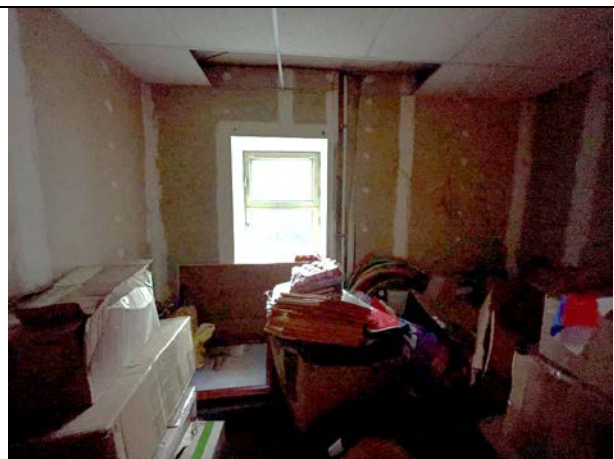
Фото 24. Типичное состояние Объекта оценки
