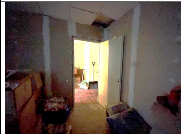
Фото 25. Типичное состояние Объекта оценки
